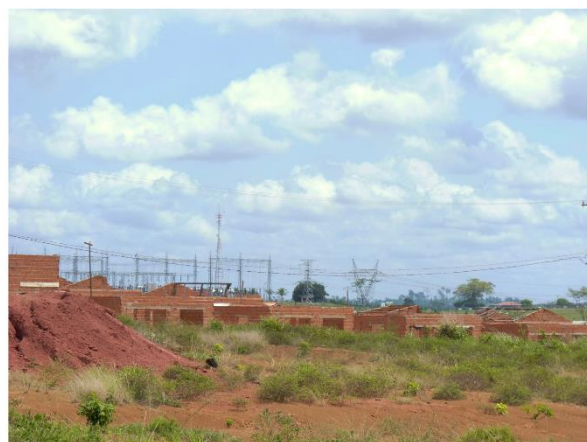
2. Casas em construção no Ilha do Arapujá Fonte: Trabalho de Campo realizado em 04/08/2016
