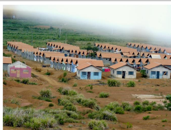
1. Residências no ocupadas no Ilha do Arapujá (ainda em construção) Fonte: Trabalho de Campo realizado em 04/08/2016
