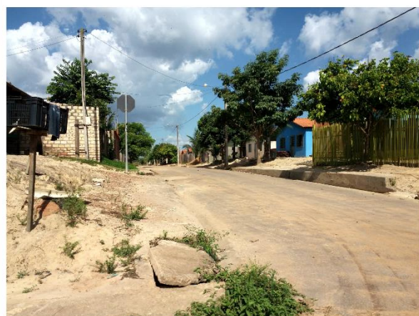
3. Calçadas deterioradas no residencial Santa Benedita Fonte: Trabalho de Campo realizado em 04/08/2016
