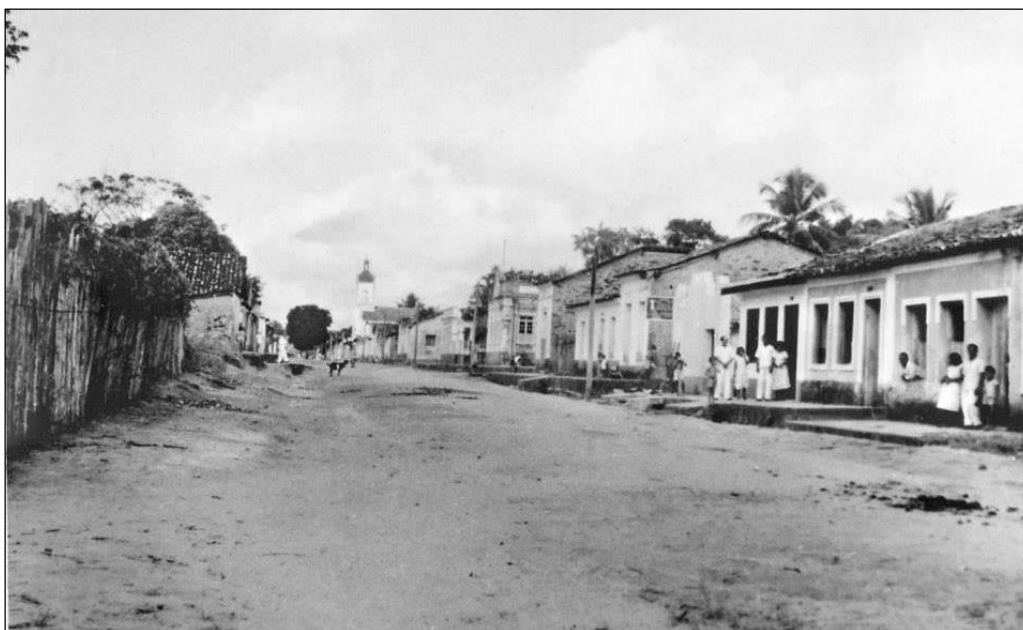
Figura 7– Avenida Cel. José Porfírio em 1940
