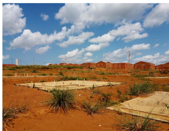
4. Bases das casas a serem construídas no Ilha do Arapujá Fonte: Trabalho de Campo realizado em 04/08/2016
