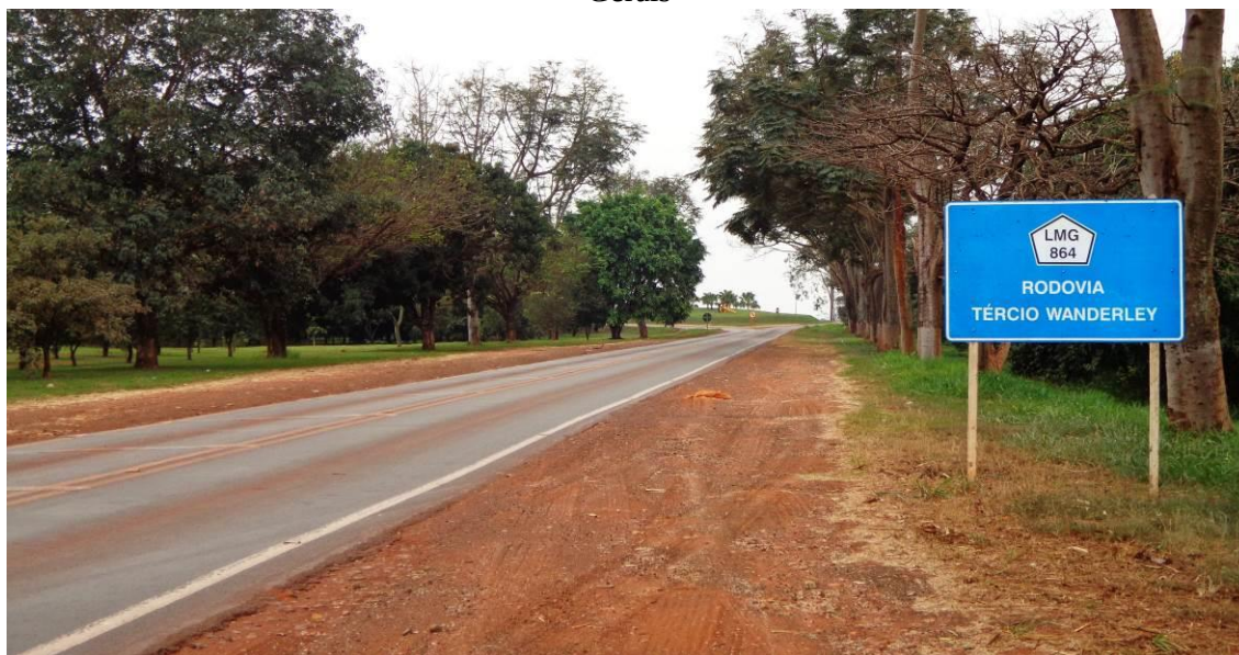
Figura 8: Iturama (MG) - trecho pavimentado com PPP, entre o GTW e o Estado de Minas Gerais
