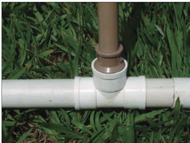
Figura 10 – Bucha de redução 40 mm × 25 mm marrom para acoplamento da haste
