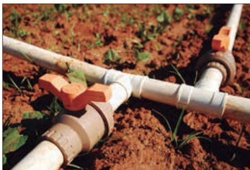
Figura 8 – Linhas laterais, dotadas de registro plástico de esfera, instaladas em conexões tê ao longo da linha de derivação
