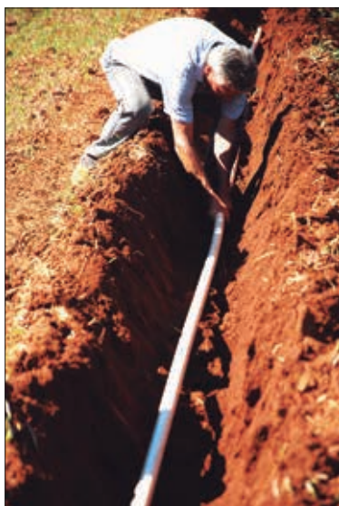
Figura 5 – Instalação da tubulação no sulco aplicando lubrificante sólido para executar a conexão dos tubos
