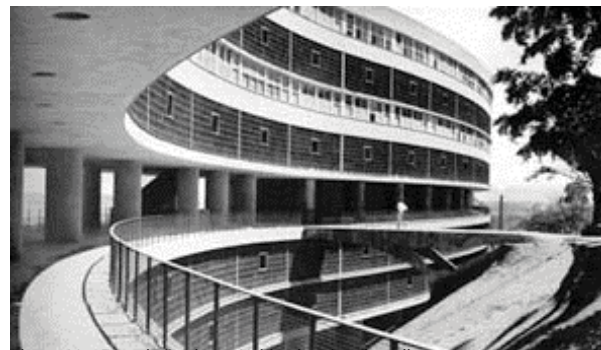
Figura 11 – Foto do Conjunto Habitacional Pedregulho Auto Carmem Portinho
