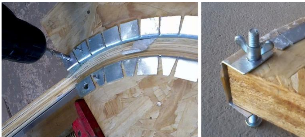
Figura 109. Furação das tiras de alumínio para fixação nos moldes e parafuso de fixação.
