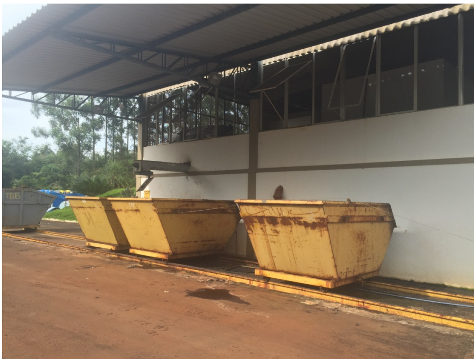
Figura 3 - Saída da centrífuga e acondicionamento do lodo em caçambas Fonte: Acervo pessoal, 2015.
