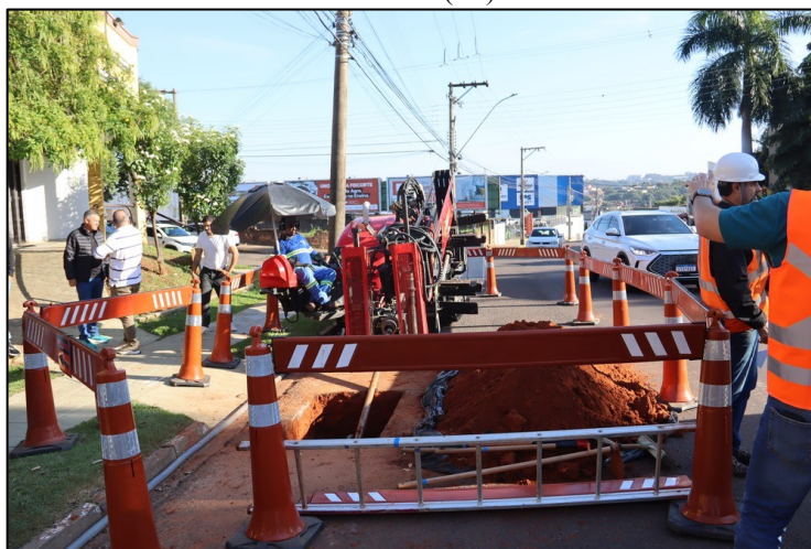
Figura 7 - Início das obras de implantação do gasoduto de biometano na Rua Dr. Cyro Bueno, em Presidente Prudente (SP)
