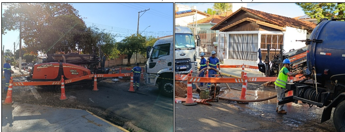
Figura 8 - Obras de implantação do gasoduto de biometano no cruzamento das ruas Barão do Rio Branco e Reverendo Coriolano, em Presidente Prudente (SP)
