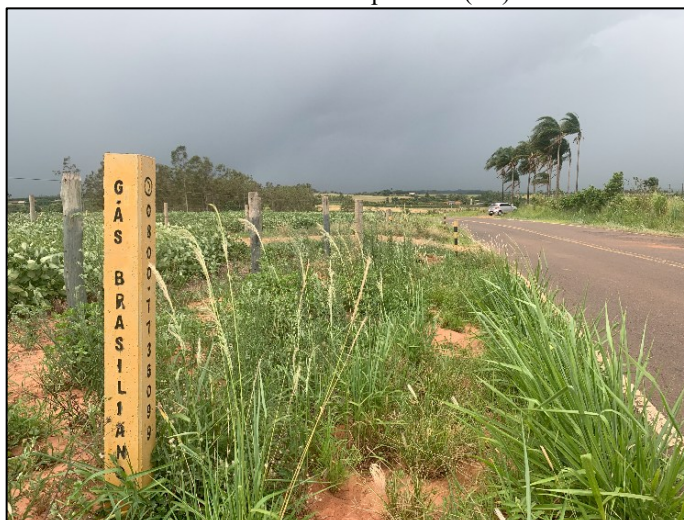
Figura 6 - Marco de sinalização do gasoduto da Necta, localizado às margens da estrada vicinal que liga Narandiba a Pirapozinho (SP)
