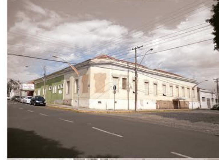
Figura 20_ O atual Hotel São Bento, onde se pode perceber o fechamento de algumas das janelas de sua edificação original. Fonte_ Acervo pessoal. Modificada.
