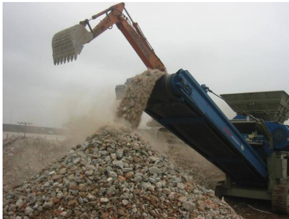
Figura 3: Resíduos de Construção e Demolição
