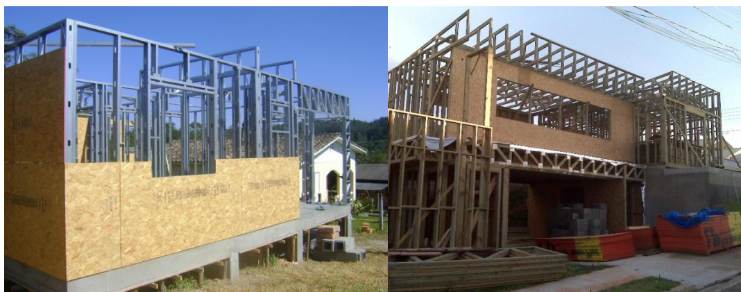
Figura 20: Casas construídas com Steel frame e Wood frame
