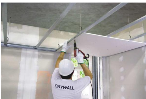
Figura 19: Teto e paredes de drywall
