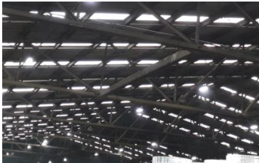
Figura 11: CBS após a instalação das luminárias.
