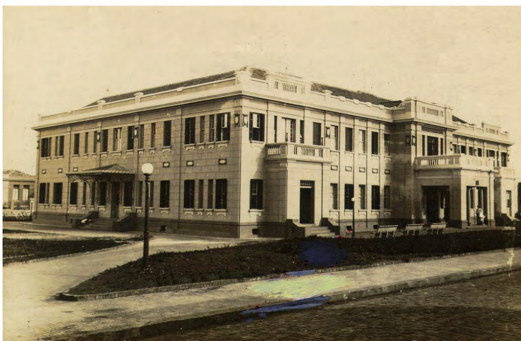
Figura 12 – Hotel Francano em 1954. Inaugurado em 1929 e demolido em 1981 (MHMF, foto 29, álbum 4).
