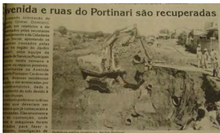
Figura 39 – Perda de equipamentos públicos em boçoroca do Jd. Portinari (DIÁRIO DA FRANCA, 31.1.1997).
