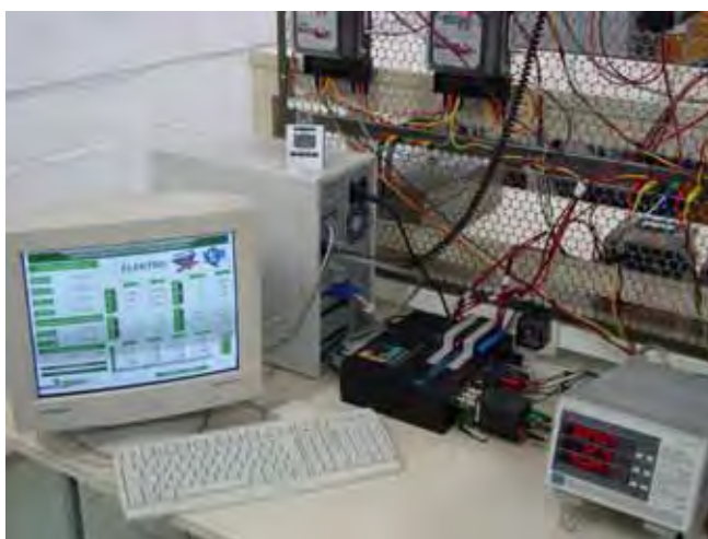
Figura 3.12 - Detalhe do “arranjo geral de ensaio” para os medidores de energia eletrônicos
