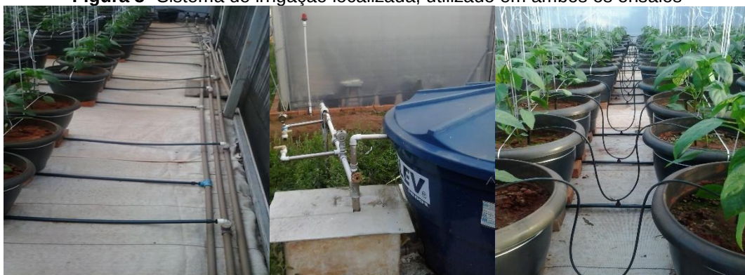
Figura 3- Sistema de irrigação localizada, utilizado em ambos os ensaios
