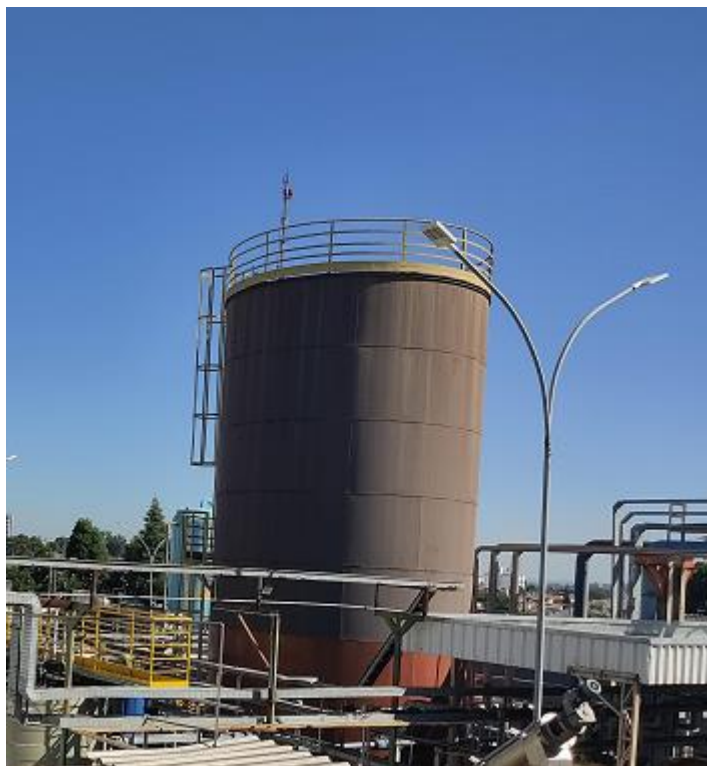
Figura 3 - Tanque de equalização.
