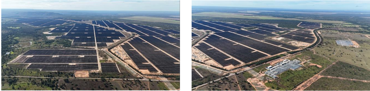
Figura 8 – Área de Instalação de painéis fotovoltaicos em Arinos - MG
