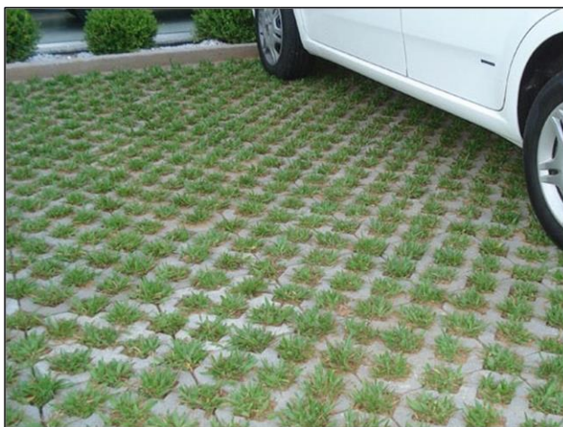
Figura 4. Pavimento permeável de betão alveolar.
