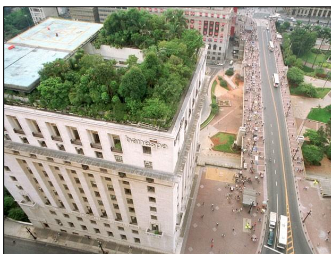
Figura 5. Telhado verde construído no edifício Matarazzo, atual sede da Prefeitura de São Paulo e antigo prédio do Banespa.
