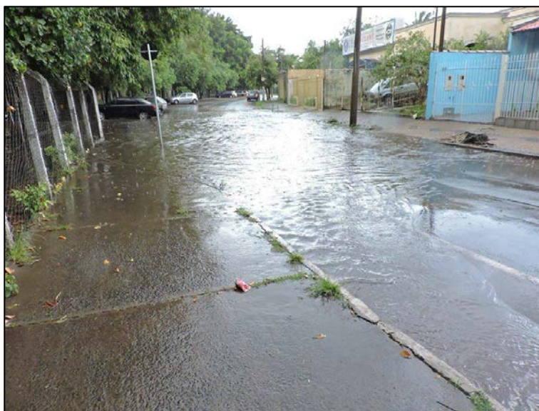
Figura 19. Ponto de alagamento localizado na Rua 1-A, entre as Avenidas 32 e 36, no Lago Azul.
