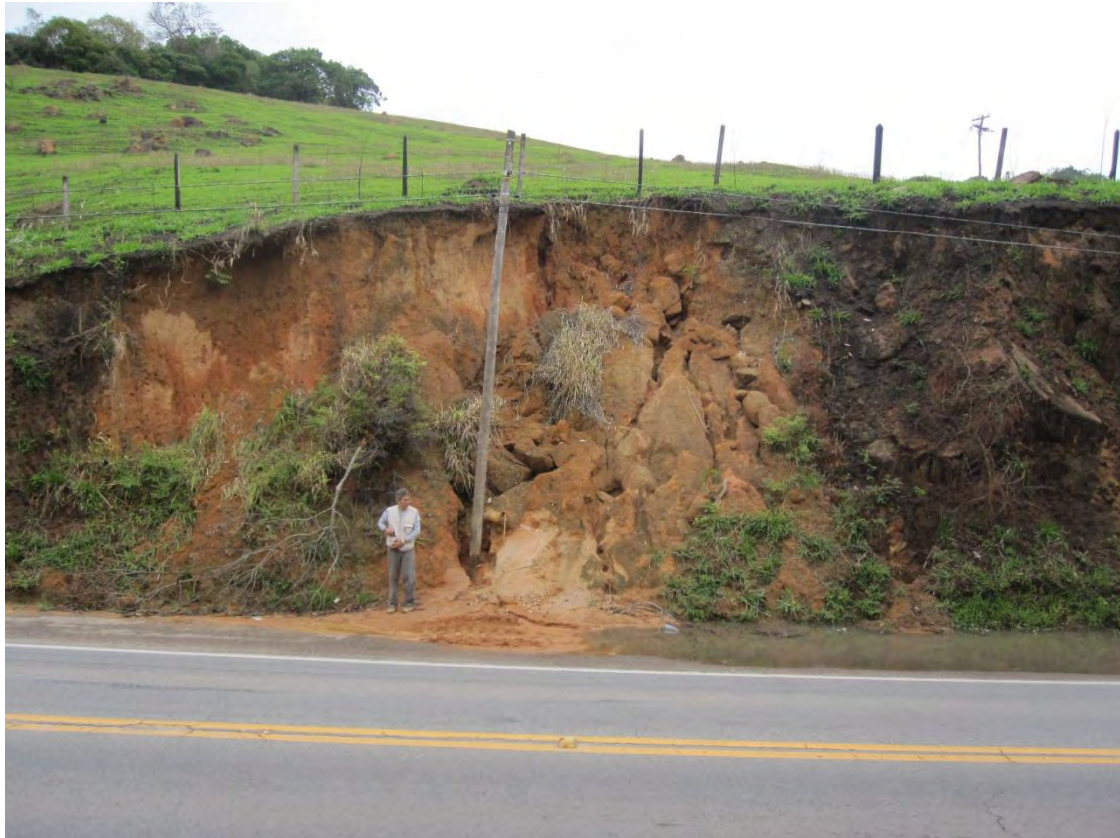
Foto 8 – Detalhe de escorregamento de solo e rochas (ponto 4).
