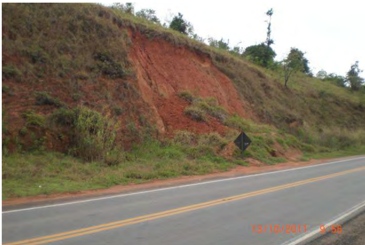
Foto 5 – Escorregamento planar de solo (ponto 1) em corte de estrada (SP-360).
