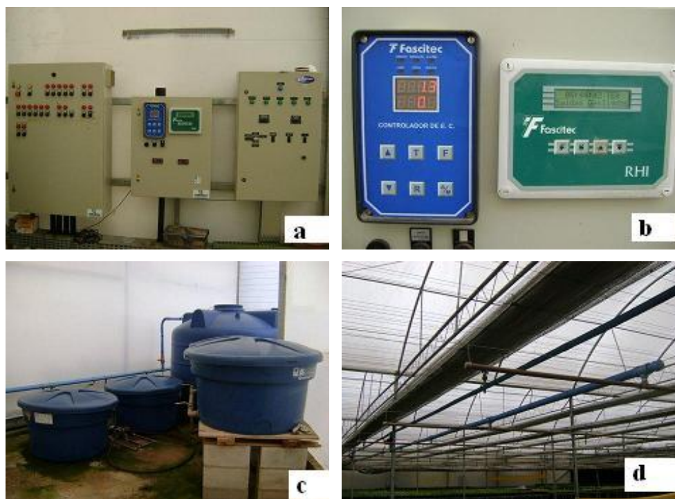
Figura 2. Equipamentos para fertirrigação da propriedade: Painel de controle (a), controlador de CE (b), tanques de mistura (c) e sistema de irrigação por microaspersão (d).
