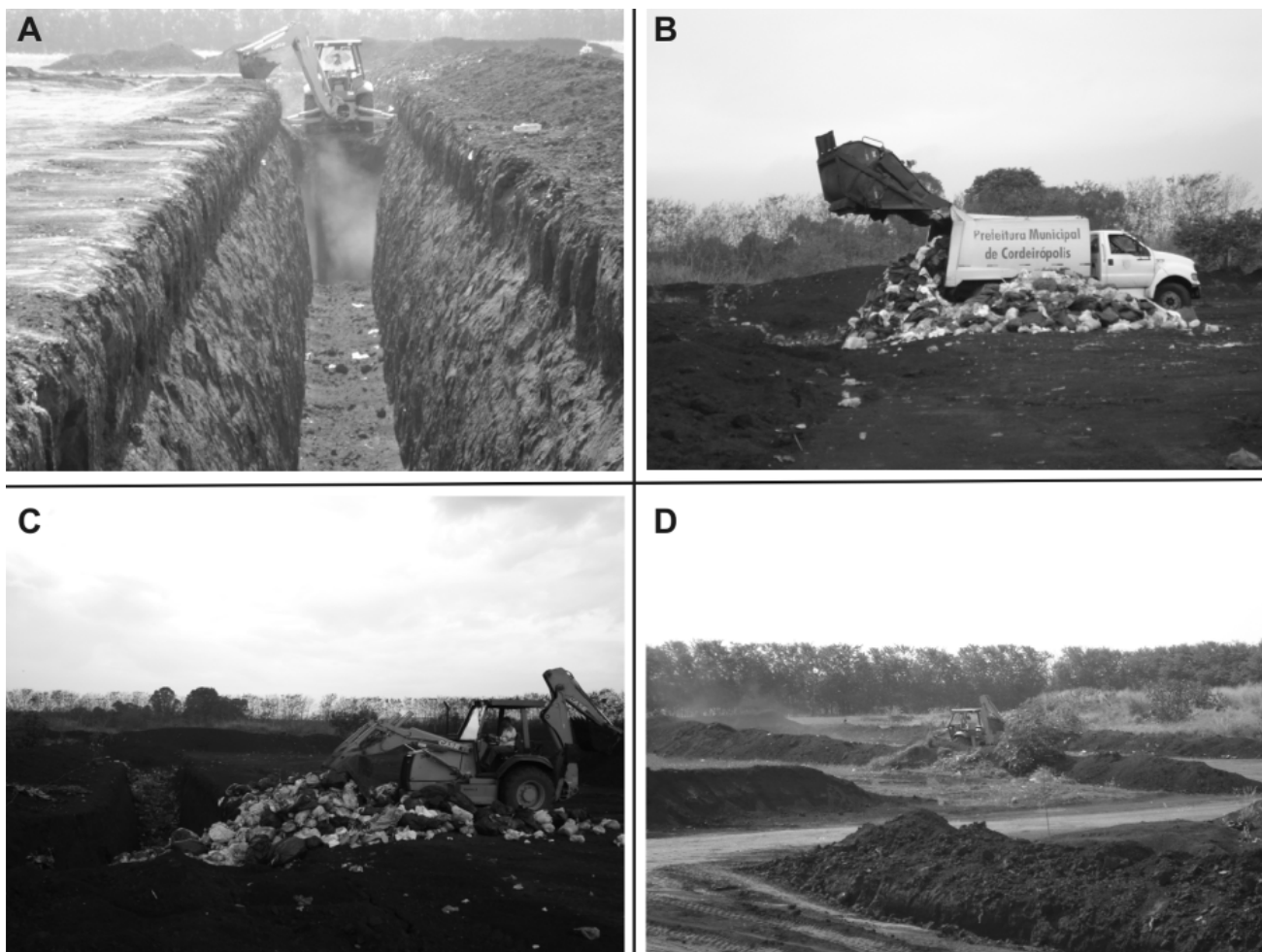
Figura 2 - Etapas de operação. A) Abertura de vala. B) Descarga de resíduos. C) Lançamento e cobertura dos resíduos. D) Valas finalizadas.
