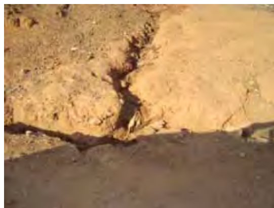
Foto 64: Estrada rural com ravinas no Bairro do Funil, em Piedade. Fonte: Pesquisa de Campo, julho de 2010.
