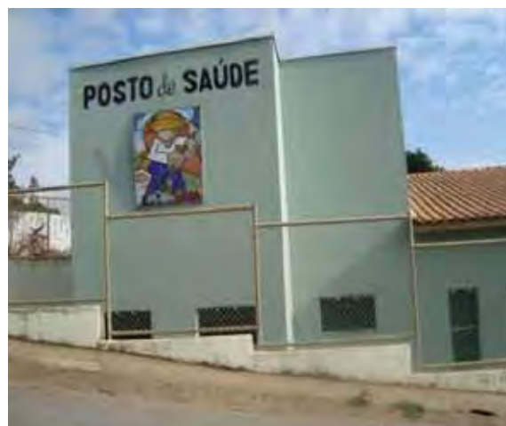
Foto 59: Posto de Saúde do Bairro dos Corrêas, em Piedade. O local presta atendimento aos moradores dos bairros próximos. Fonte: Pesquisa de Campo, julho de 2010.
