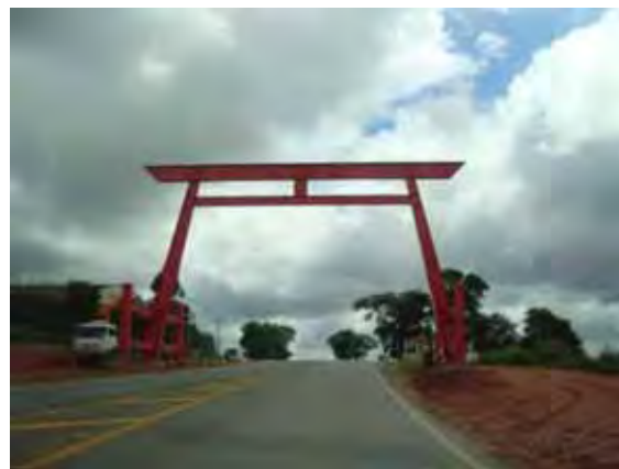
Foto 07: Portal construído na entrada do município de Piedade-SP, no sentido Tapiraí, em frente à Associação Cultural e Desportiva Nipo-brasileira de Piedade.
