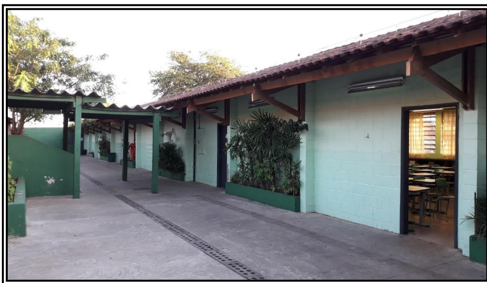
Figura 5. Corredor de salas de aula, lado direito.
