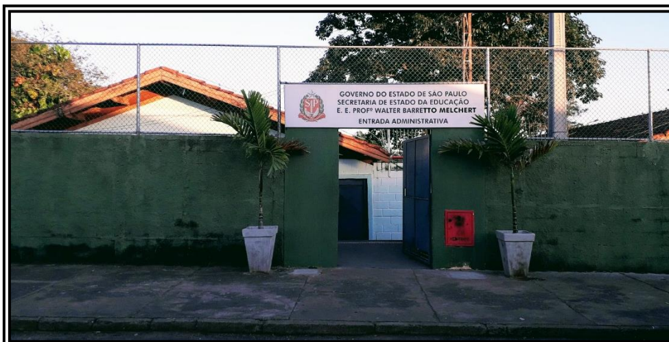
Figura 1. Fachada da Escola e Entrada administrativa.
