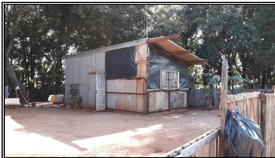
Figura 38. Moradia em lona e placas de MDF no Acampamento Morada Nova.
