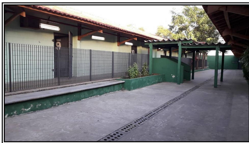
Figura 6. Corredor de salas de aula, lado esquerdo.
