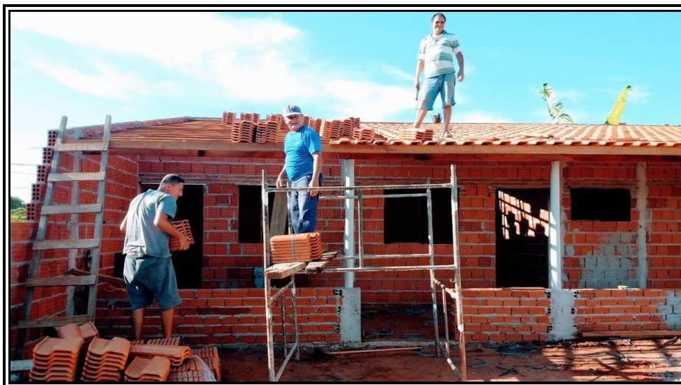
Figura 27. Mutirão para construção de moradia em alvenaria no acampamento Crystal.
