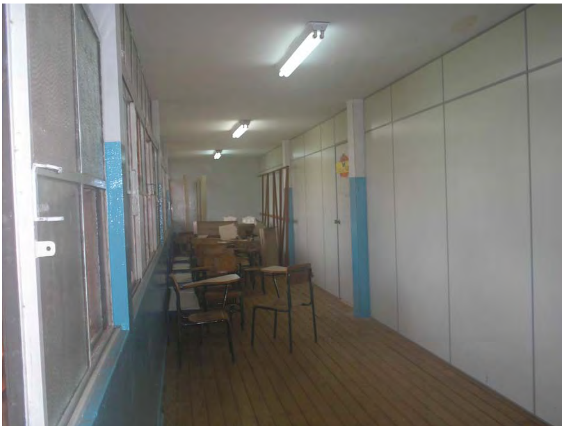
Foto 4 - Corredor Final de acesso a um dos blocos das Salas de Aulas. (Fonte da autora).
