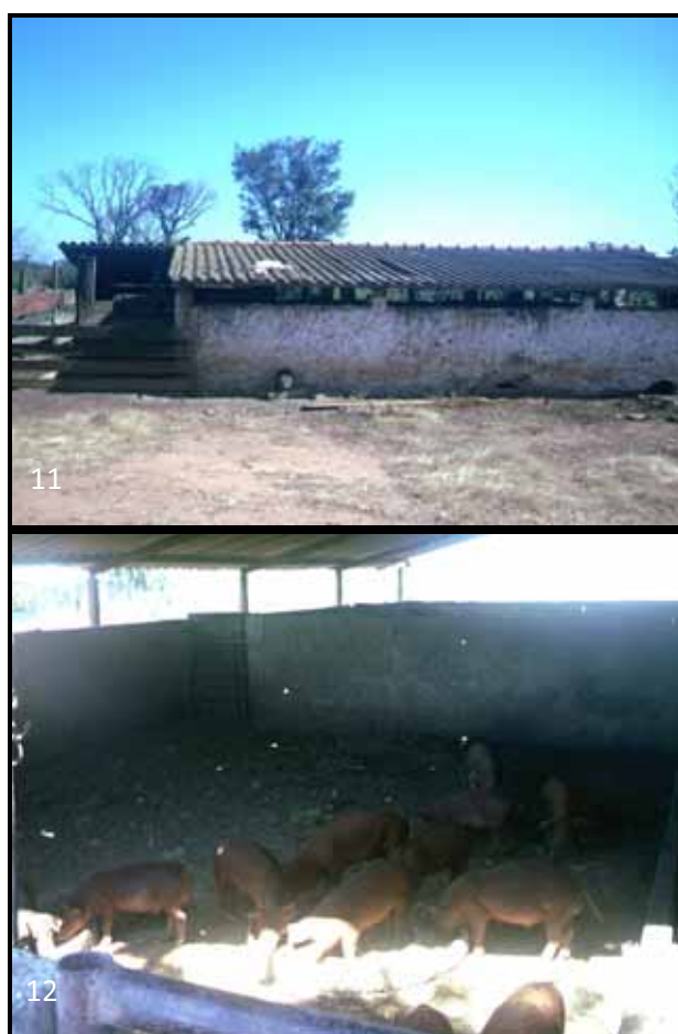
Fotos 11 e 12 – Instalações de menor porte e uso do leito de diversos materiais, evitando contato direto dos suínos com o chão. Fotografia: J. M. Sanabria, 08/2009.
