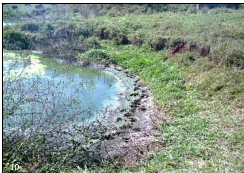
Foto 10 – Ausência de impermeabilização das lagoas de estabilização da propriedade 2, permitindo a percolação dos poluentes. Fotografia: J. M. Sanabria, 08/2009.
