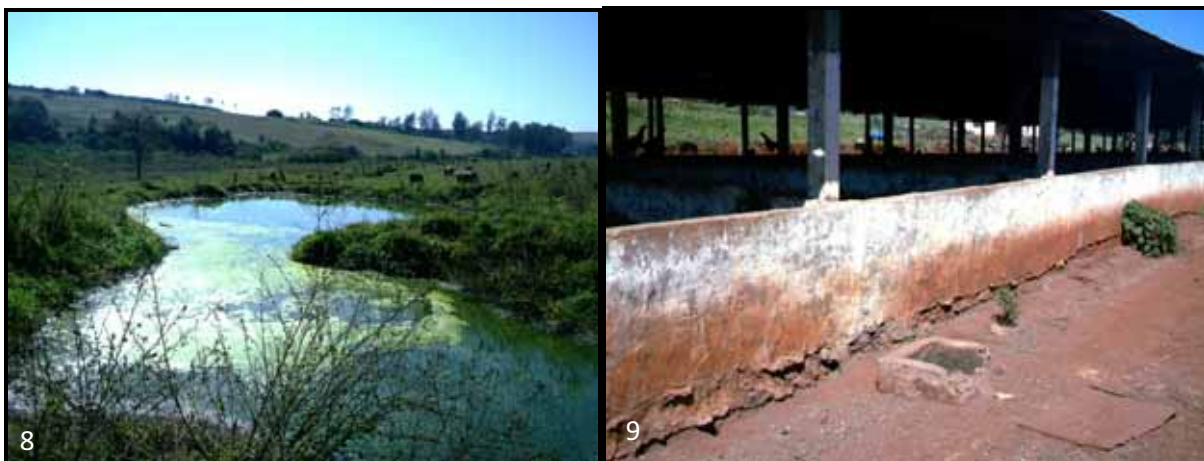
Fotos 8 e 9 – Aspectos que revelam a precariedade das instalações e equipamentos do sistema de tratamento de dejetos na propriedade 2. Fotografia: J. M. Sanabria, 08/2009.
