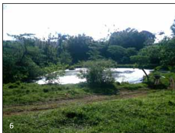
Fotos 5 e 6 – Sistema de tratamento dos dejetos com decantador (foto 5) e lagoa de estabilização (foto 6). J.M. Sanabria, 08/2009.
