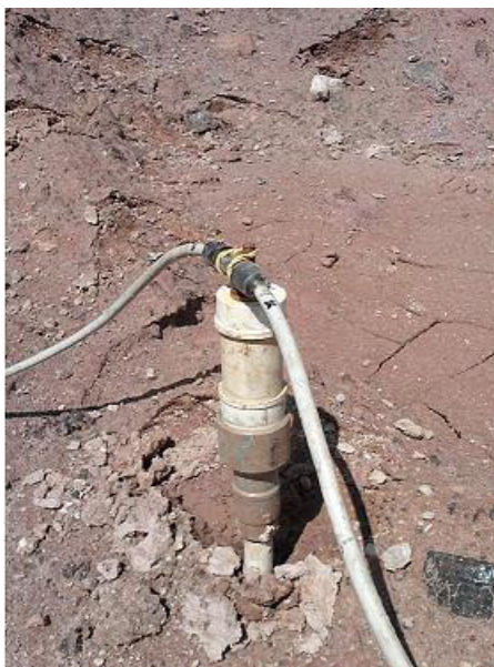
Figura 10: Eletrodo com de sulfato de cobre montado. Fonte: arquivo pessoal.
