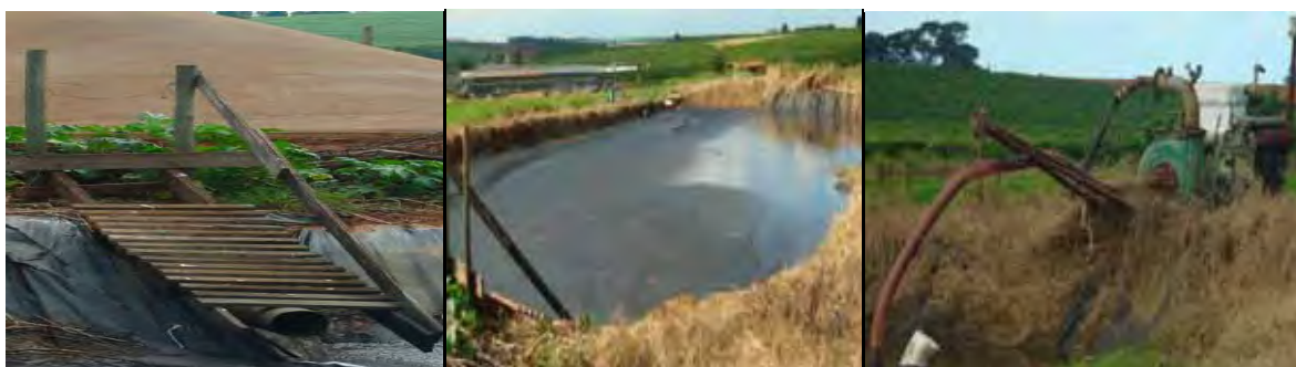
Figura 7. Efluente do biodigestor, reservatório e moto-bomba.
