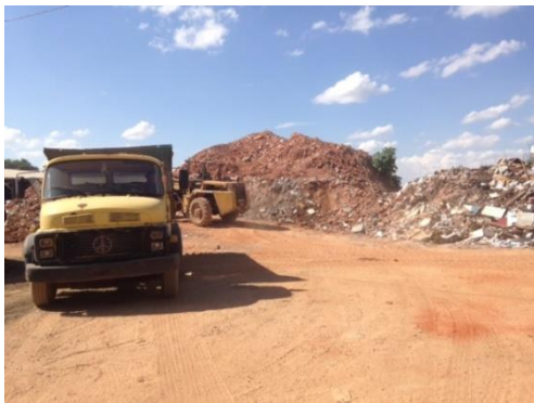
a) chegada de materiais.
