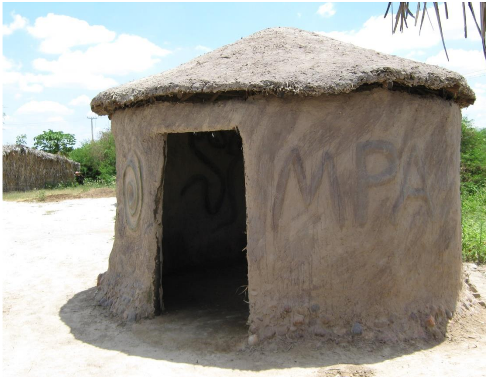
Foto 08 - Primeiras bioconstruções do Terra Nossa, na época da ocupação. Biblioteca com técnicas mistas
