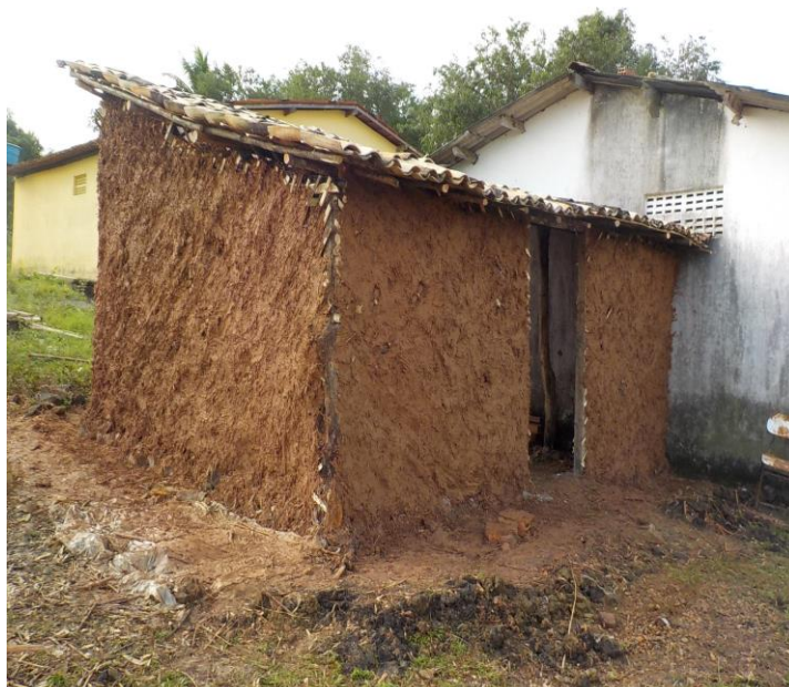
Fotos 18 -. Finalizando os primeiros rebocos na cozinha comunitária de Engenho da Ponte
