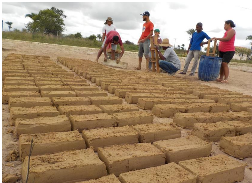
Foto 9 - Adobes feitos na construção do espaço de reunião no Assentamento Terra Nossa
