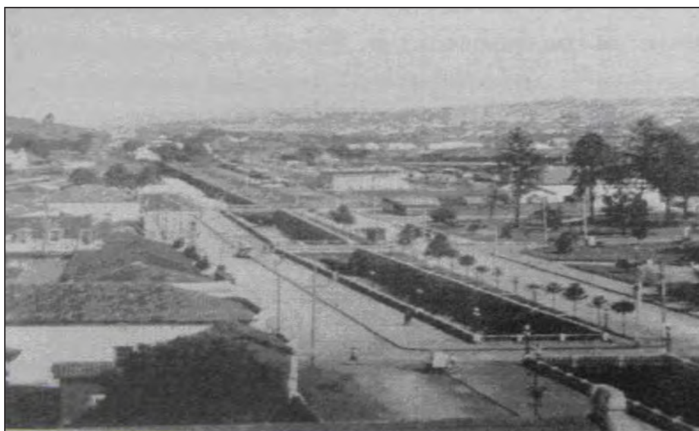
Figura 4. Obra de retificação e canalização na cidade. Fonte: Arquivo Histórico do Município de Ribeirão Preto.
