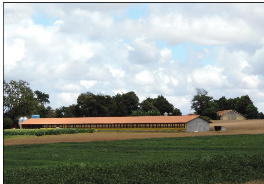
Figura 12 - Aviário de engorda de frangos
