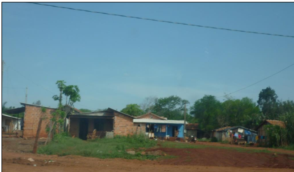
Figura 22 - Estrutura das moradias em bairro onde residiam trabalhadores de frigoríficos em São Clemente, distrito do município de Santa Helena (PR)
