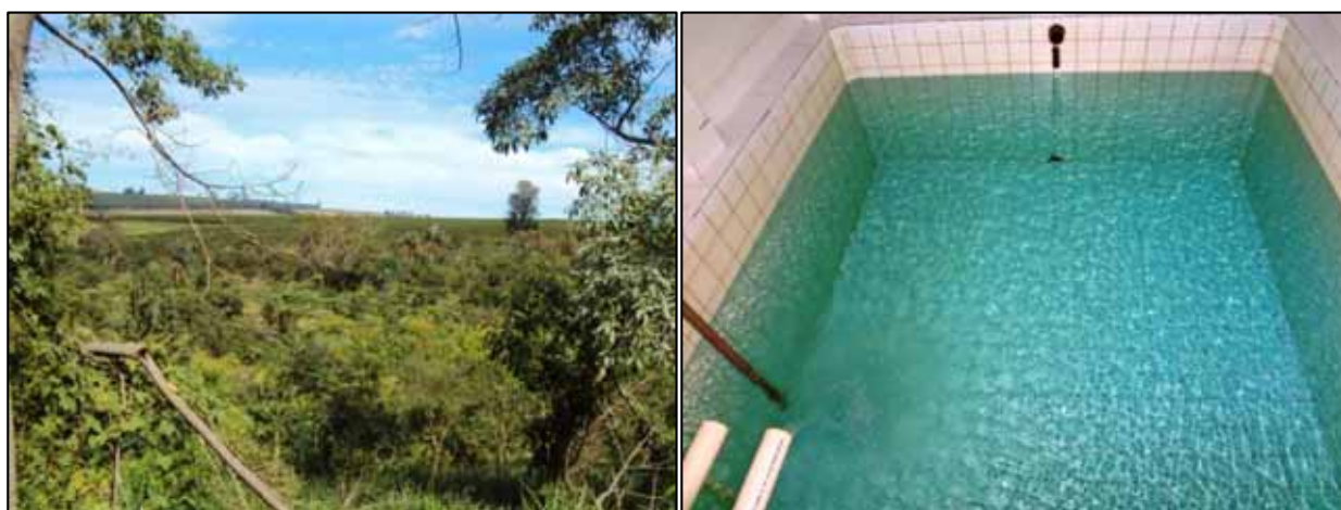
Figura 29. Nascente com vegetação nativa no entorno ao qual há captação da água da mina para a população em caixa devidamente protegida.
