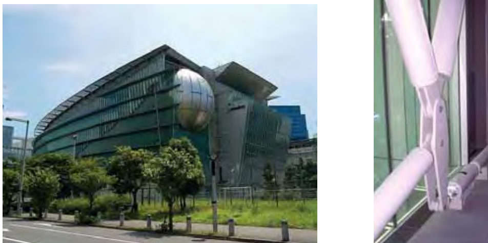
Figura 1.1 – Museu Nacional Japonês e amortecedores MR instalados.
