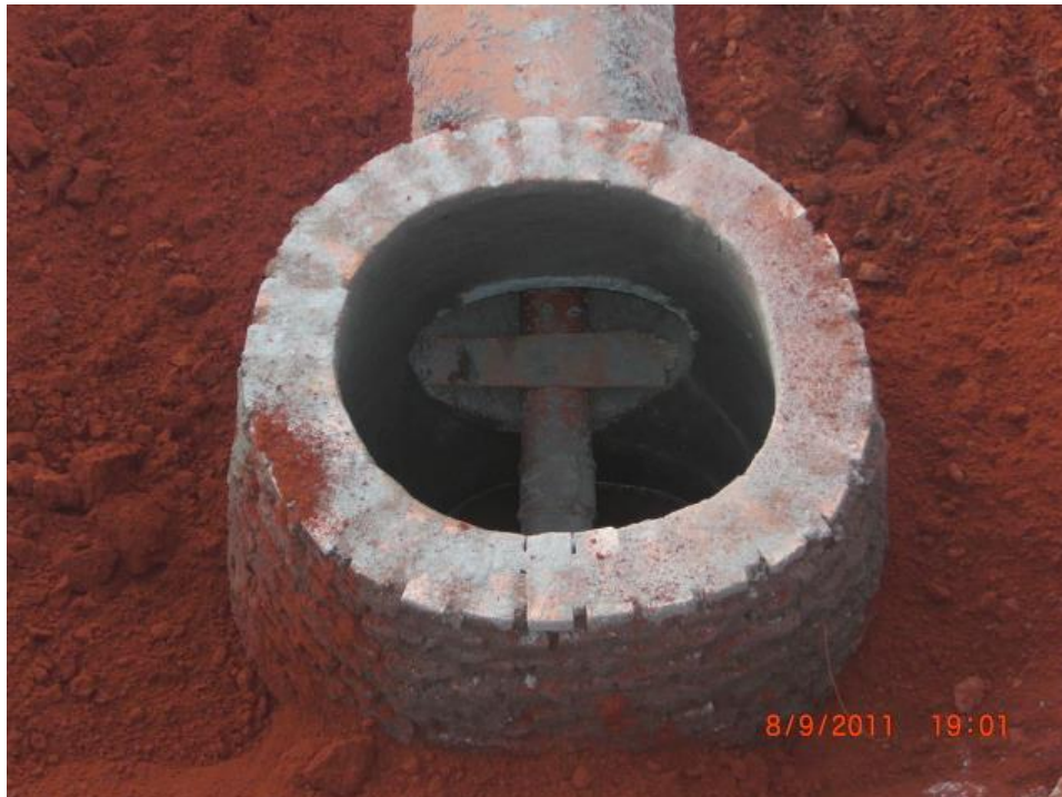
Figura 6 - Exemplo de poço de visita
