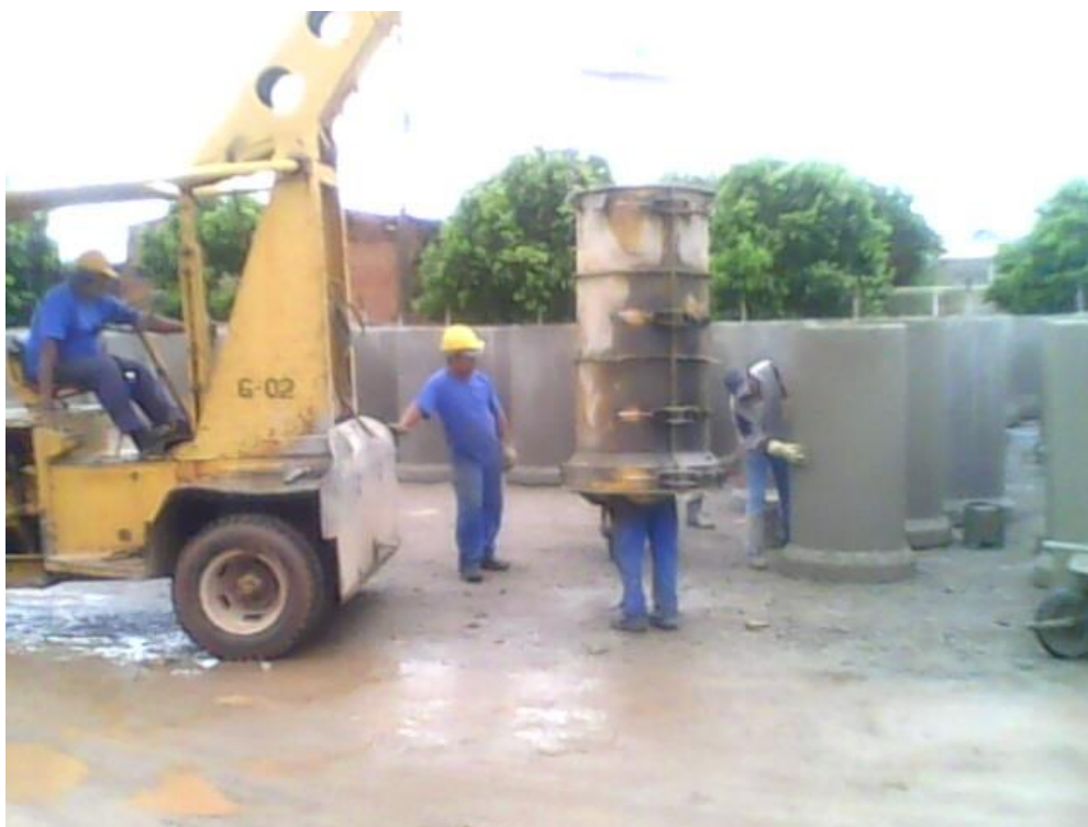
Figura 15 - Tubo de concreto sendo transportado e sendo feito o acabamento interno
