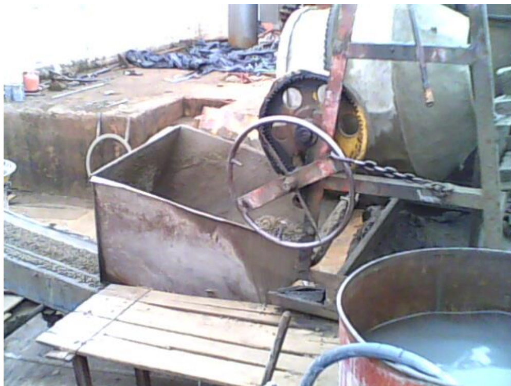
Figura 27 - Detalhe da betoneira onde é feita a mistura dos materiais e a caixa onde cai o concreto
