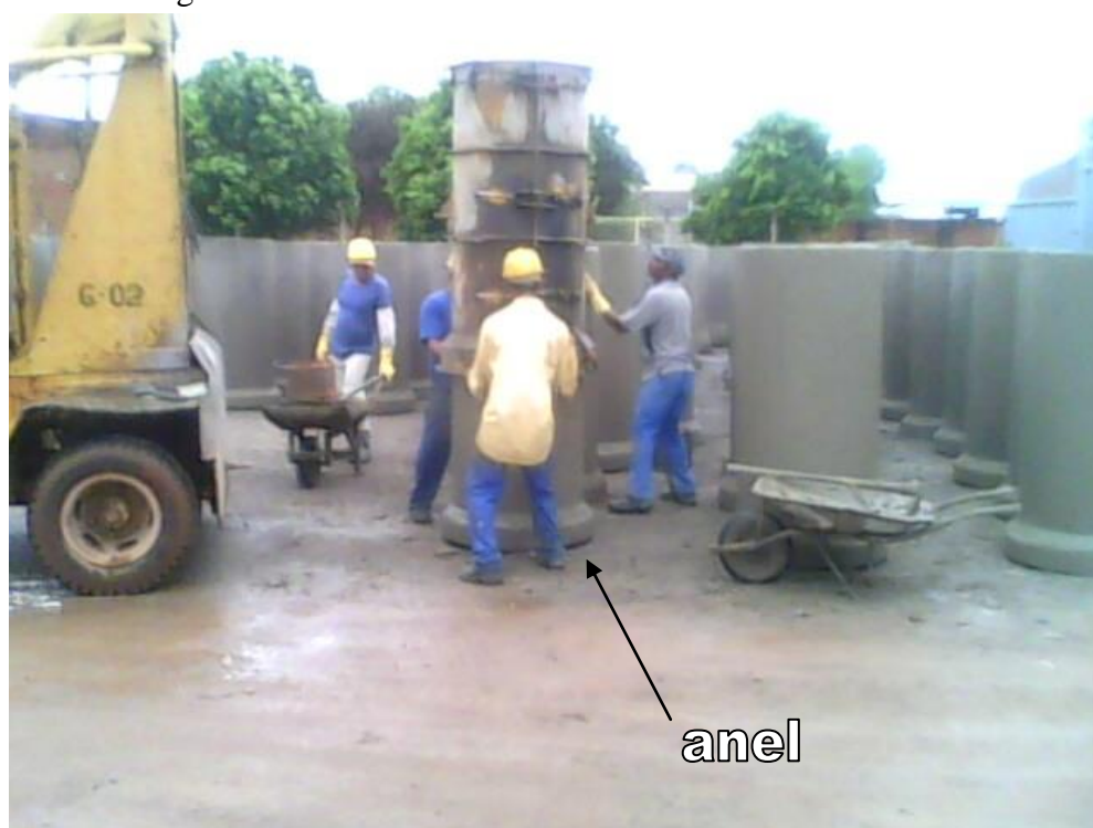
Figura 16 - Retirada da fôrma externa do tubo de concreto
