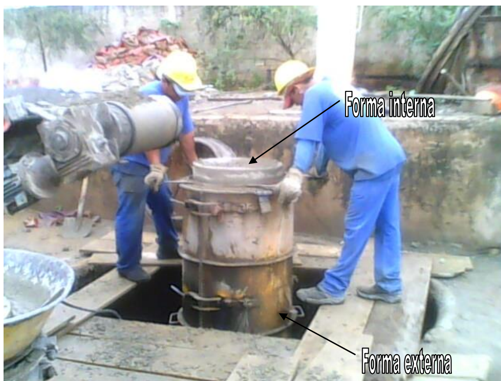
Figura 11 - Forma externa e interna (vibrador)
