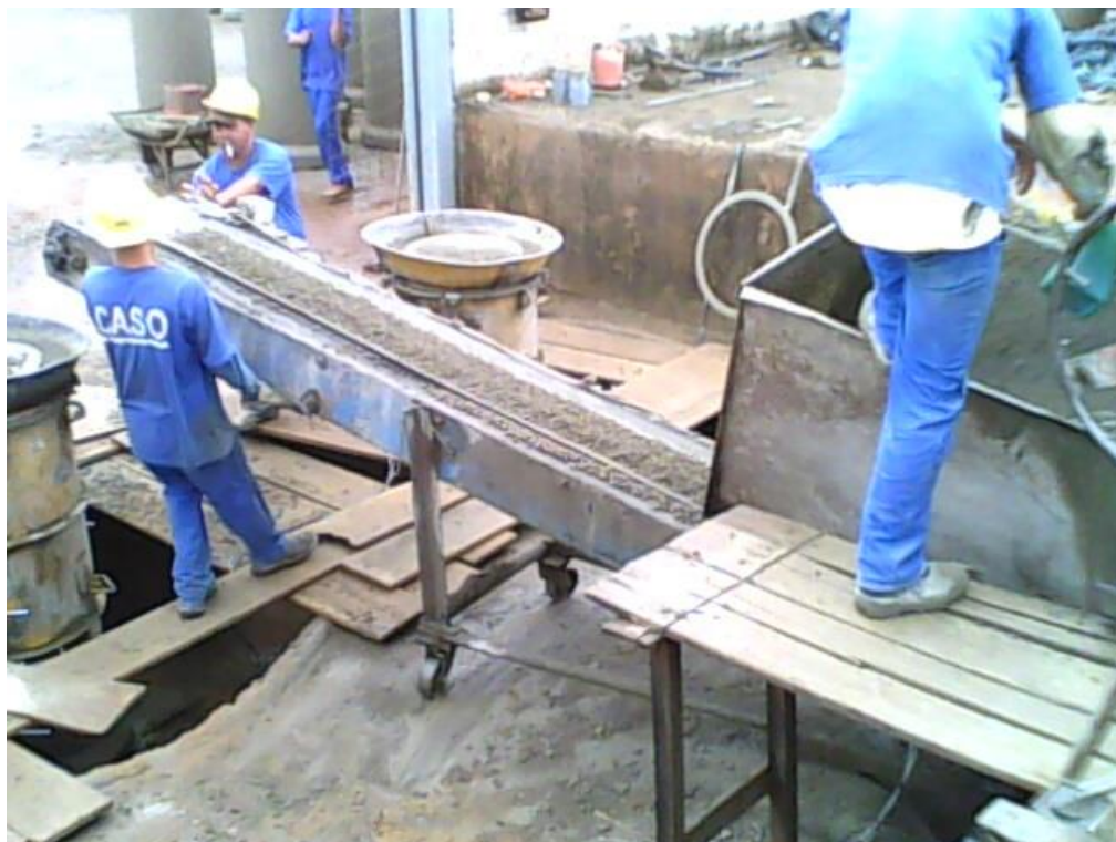
Figura 28 - Detalhe da esteira que transporta o concreto que sai da caixa até o núcleo vibratório
