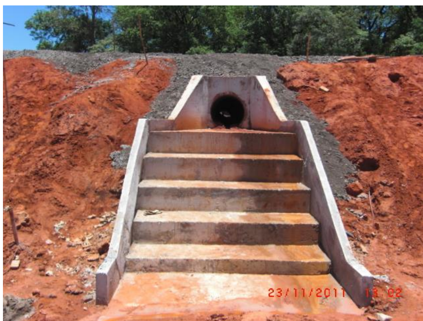
Figura 8 - Exemplo travessia com dissipador de energia
