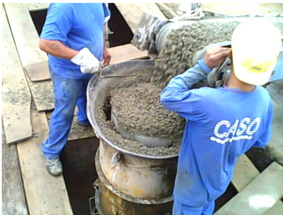
Figura 29 - Núcleo vibratório, mesmo local de vibração dos tubos e dos corpos de prova
