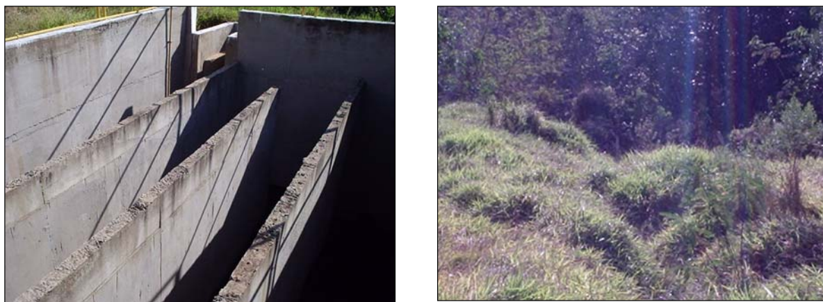
Figura 12. Da esquerda para a direita, vista do decantador (labirinto) e local de lançamento do efluente tratado, em direção ao córrego dos Cintras.
