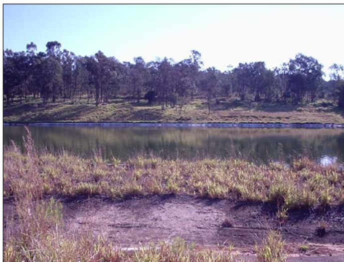
Figura 8. Vista da lagoa facultativa primária.
