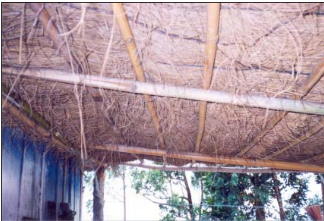
Foto 28: O Telhado de Macega
