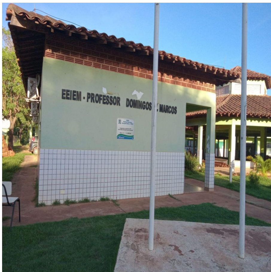
Figura 21-Fachada da Escola Estadual da aldeia Bananal.
