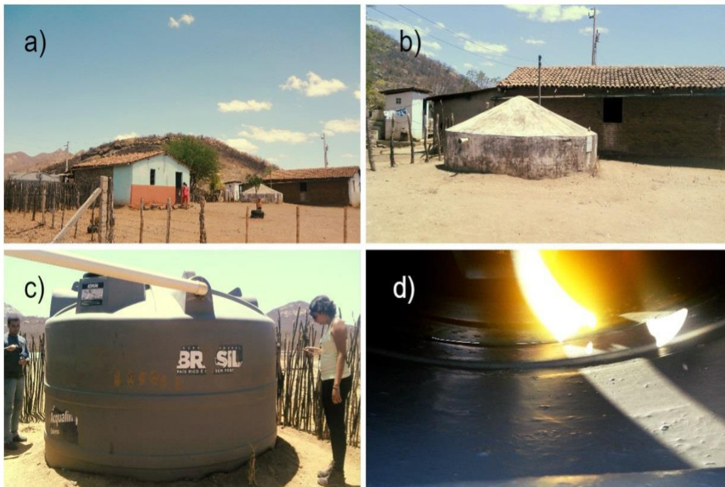
Figura 5: Cisternas de placa versus cisternas de polietileno.
