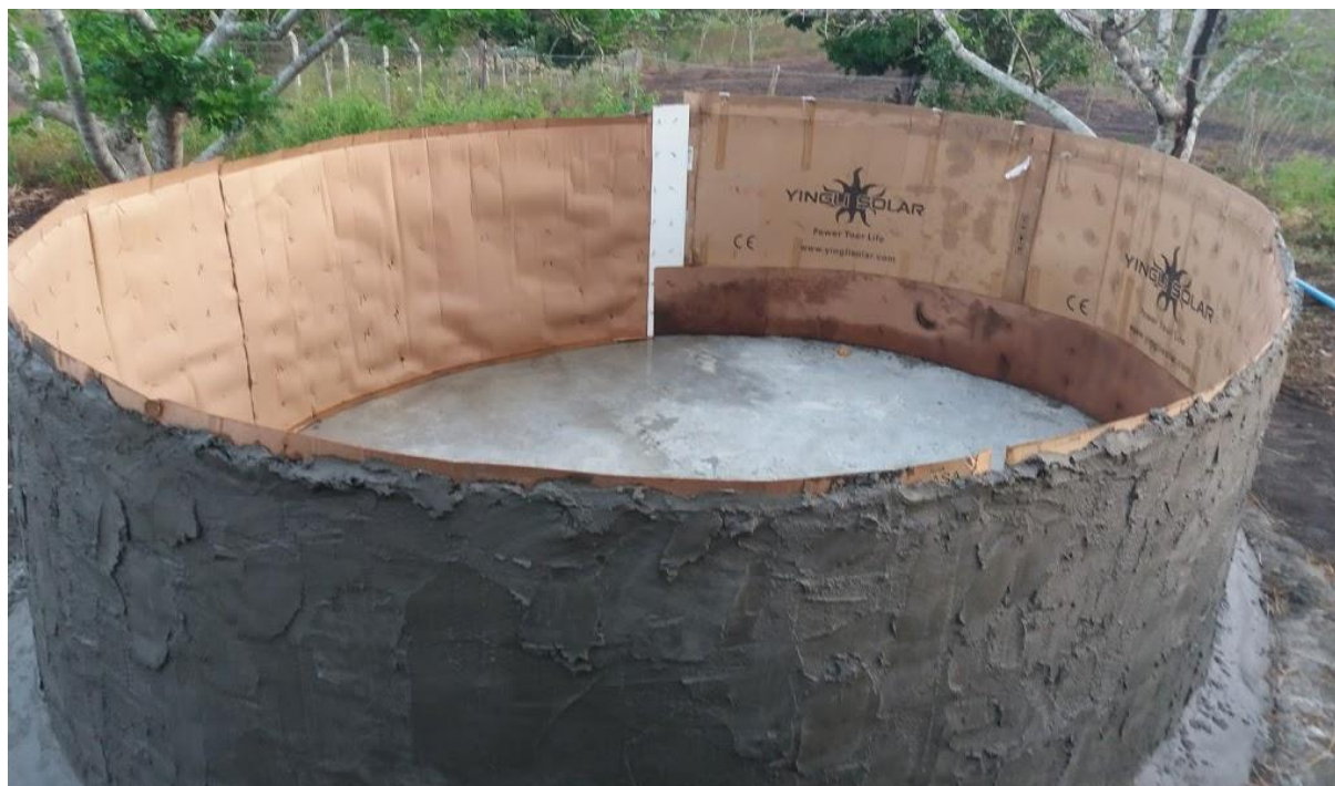
Foto 20: Cisterna de placa em construção no Centro de Formação do MST-PB.
