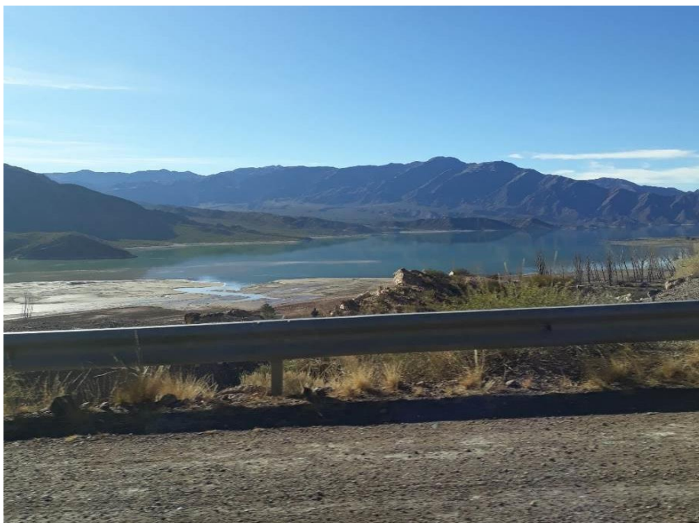
Foto 7: Dique de Potrerillos, Mendoza- Argentina.
