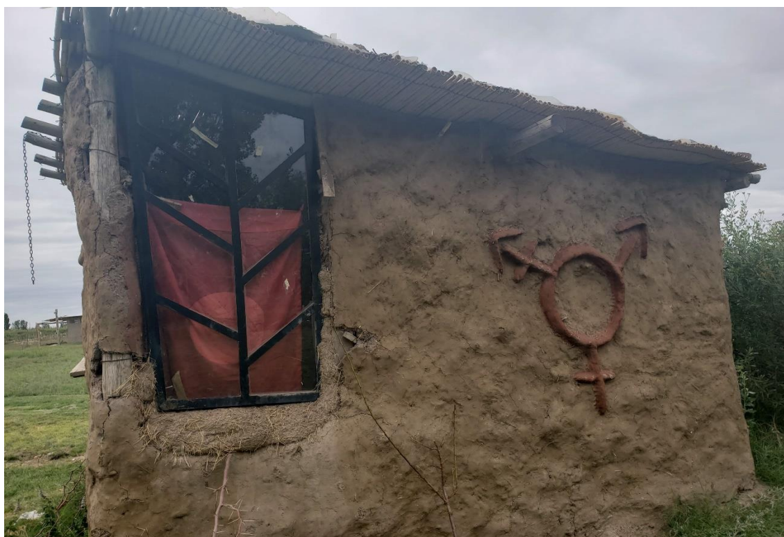
Foto 27: Parede externa do Banheiro da Escuela Campesina de Agroecologia MNCI-UST com símbolo trans.
