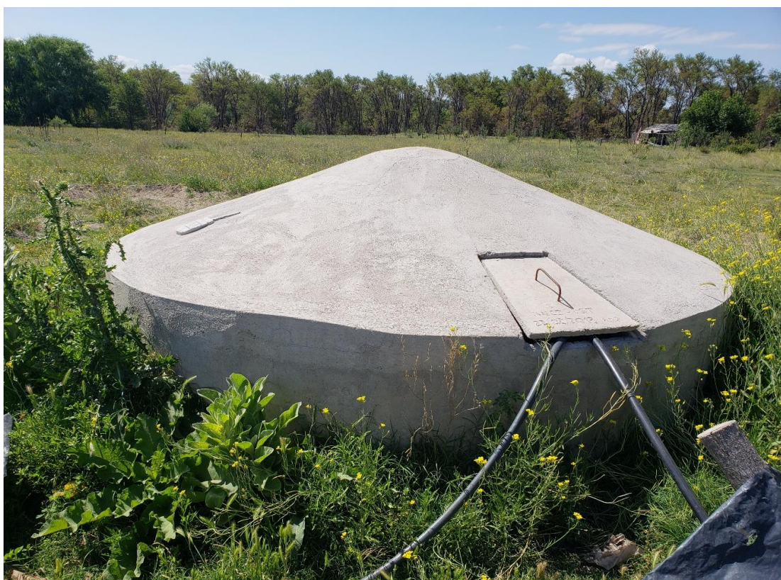
Foto 21: Cisterna de placa na sede da UST, localizada no departamento de Tupungato, Mendoza-ARG.
