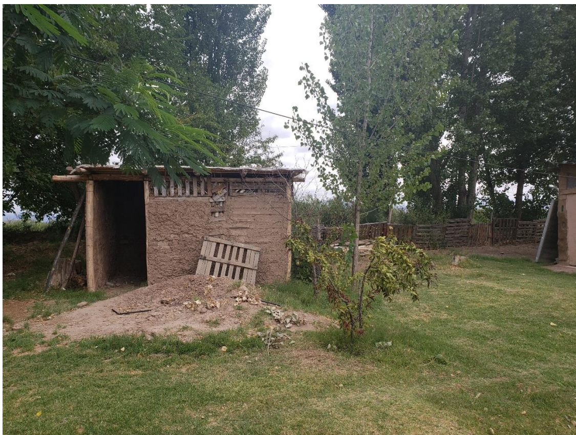
Foto 22: Casa de sementes em construção na Escola de Agroecologia da UST-MNCI.
