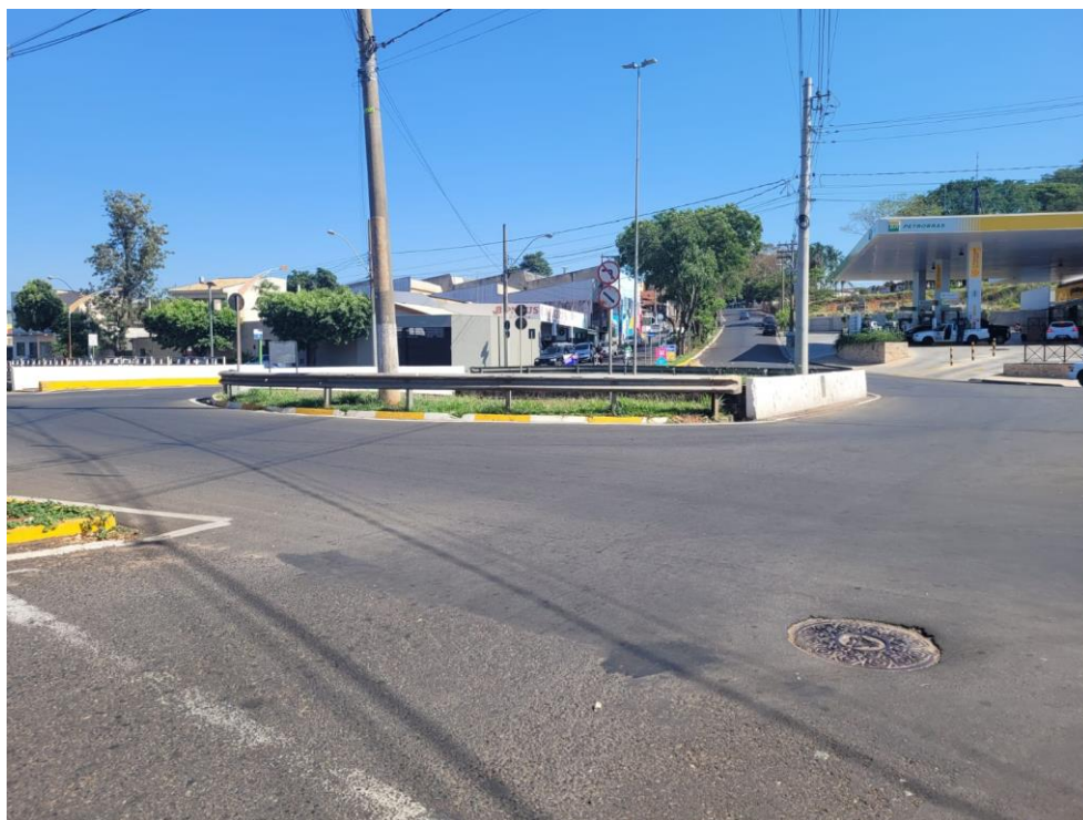
Figura 68: Rotatória entre Avenida João Cernach e Avenida Doutor Artur Cordeiro.
