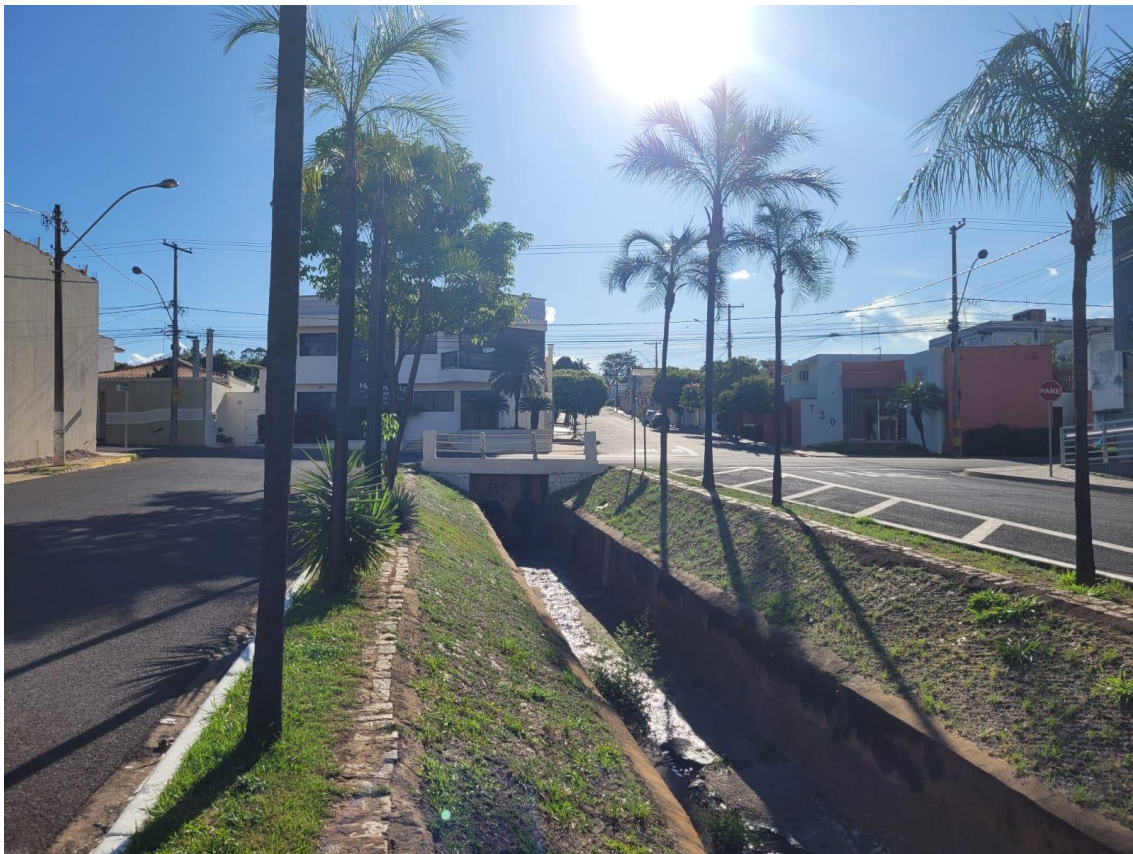
Figura 43: Córrego Biriguzinho canalizado na região da nascente.
