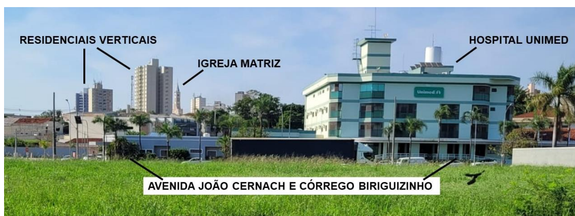
Figura 46: Hospital da Unimed, com vista para região central da cidade.
