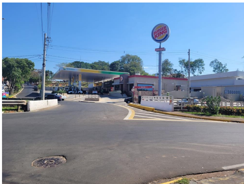
Figura 69: Rotatória entre Avenida João Cernach e Avenida Doutor Artur Cordeiro.
