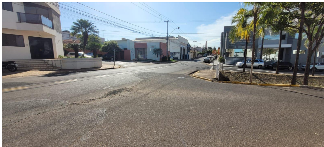
Figura 24: Nascente tamponada do córrego Biriguizinho.
