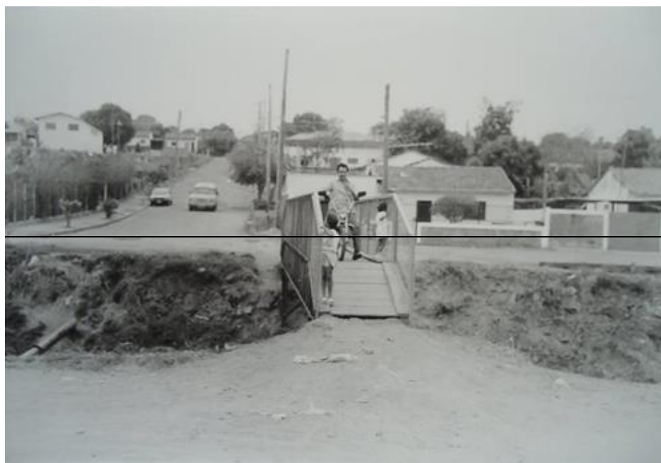
Figura 38: Ponte na Avenida João Cernach, ligando os bairros Cecap e Vila Xavier.
