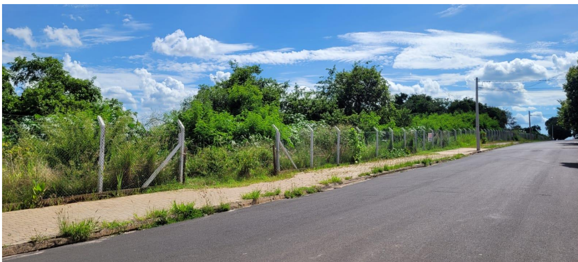
Figura 82: Parque Ecológico Valdemar Salmeirão com abertura no alambrado.
