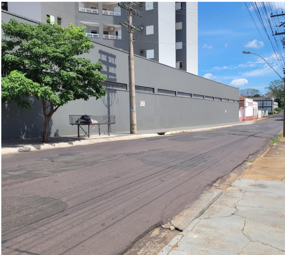
Figura 23: Nascente tamponada do córrego da Piscina.
