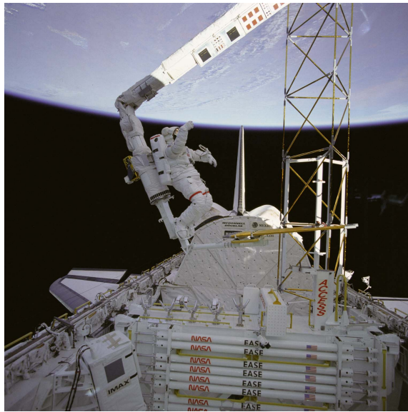
Figura 1.2: Imagem da treliça espacial montada dentro do projeto ACCESS. (Fonte: NASA Images)
