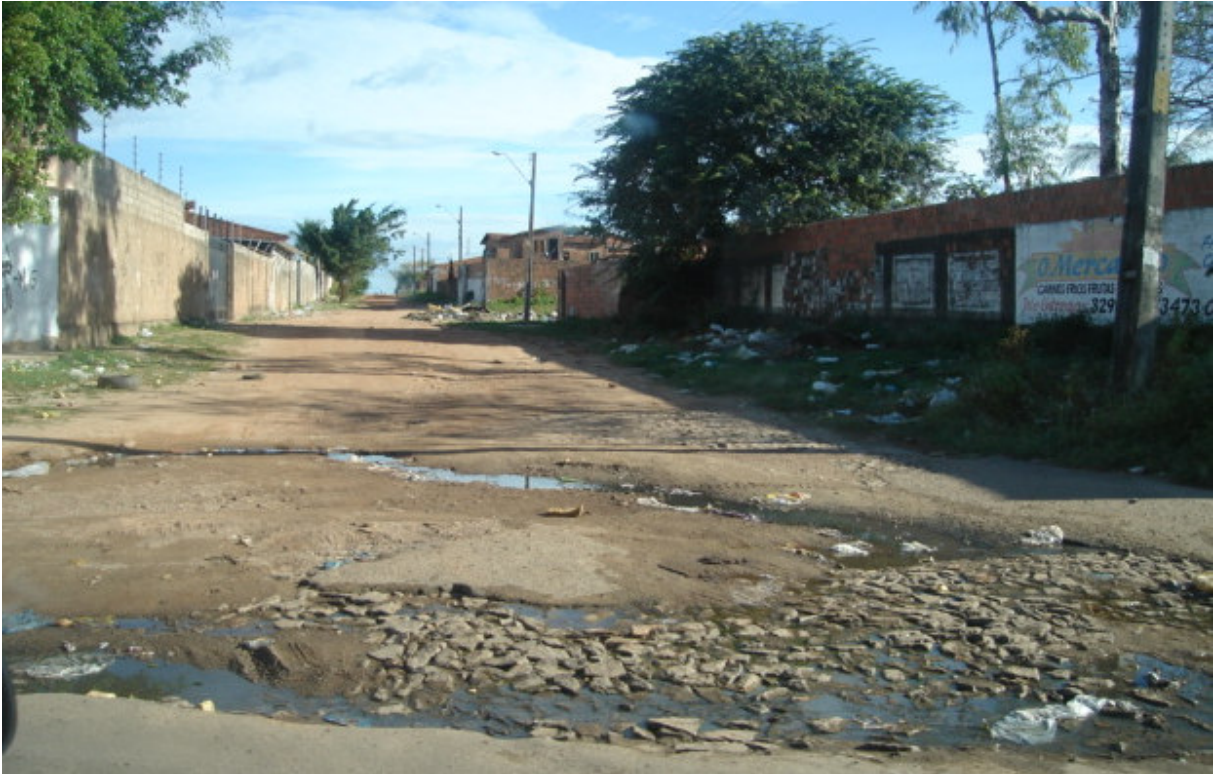
Figura 24 – Área sem infraestrutura básica, no Planalto Airton Sena - Fortaleza-CE
