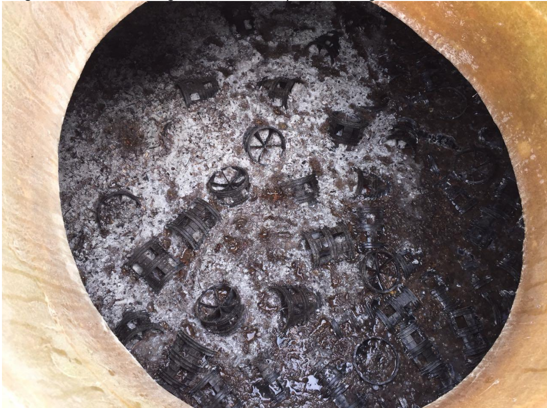
Figura 19 – Filtro biológico da ETE compacta da Lagoa Seca – Adamantina.
