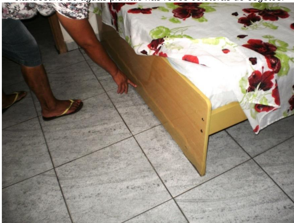
Figura 34 - Danos em móveis devido ao retorno de esgotos provocado por lançamento clandestino de águas pluviais nas redes coletoras de esgotos.
