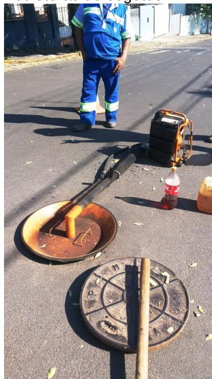
Figura 31 - Teste de fumaça para detectar lançamentos de águas pluviais para as redes coletoras de esgotos.
