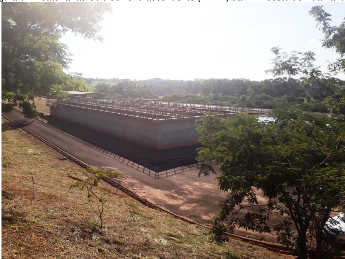
Figura 9 - Reator anaeróbico de fluxo ascendente (RAFA) da ETE oeste de Adamantina.
