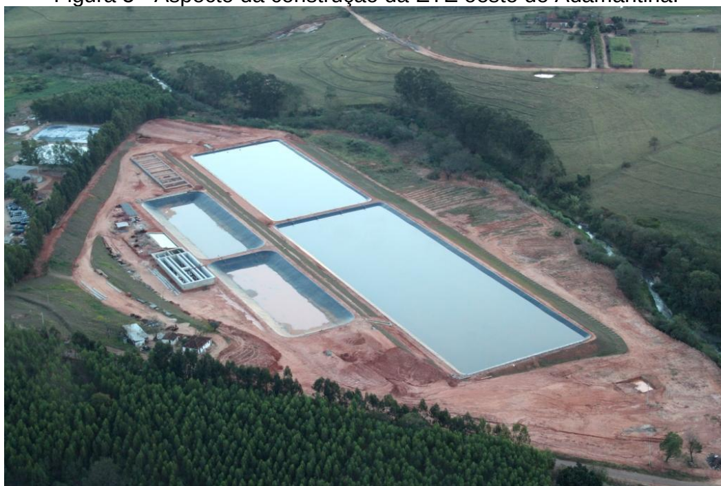
Figura 5 - Aspecto da construção da ETE oeste de Adamantina.
