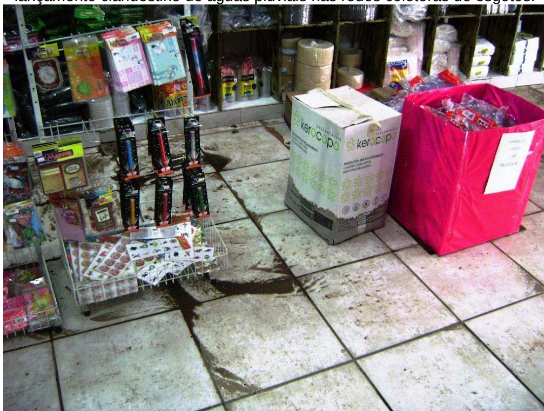
Figura 35 - Danos em mercadorias devido ao retorno de esgotos provocado por lançamento clandestino de águas pluviais nas redes coletoras de esgotos.
