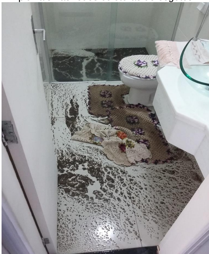
Figura 33 - Retorno de esgotos provocado por lançamento clandestino de águas pluviais nas redes coletoras de esgotos.
