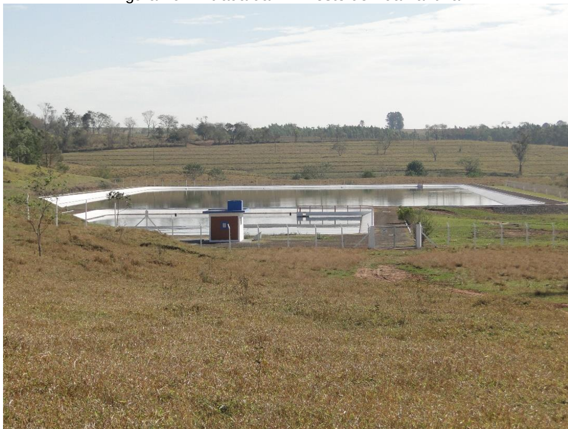
Figura 46- Entrada da ETE leste de Adamantina.
