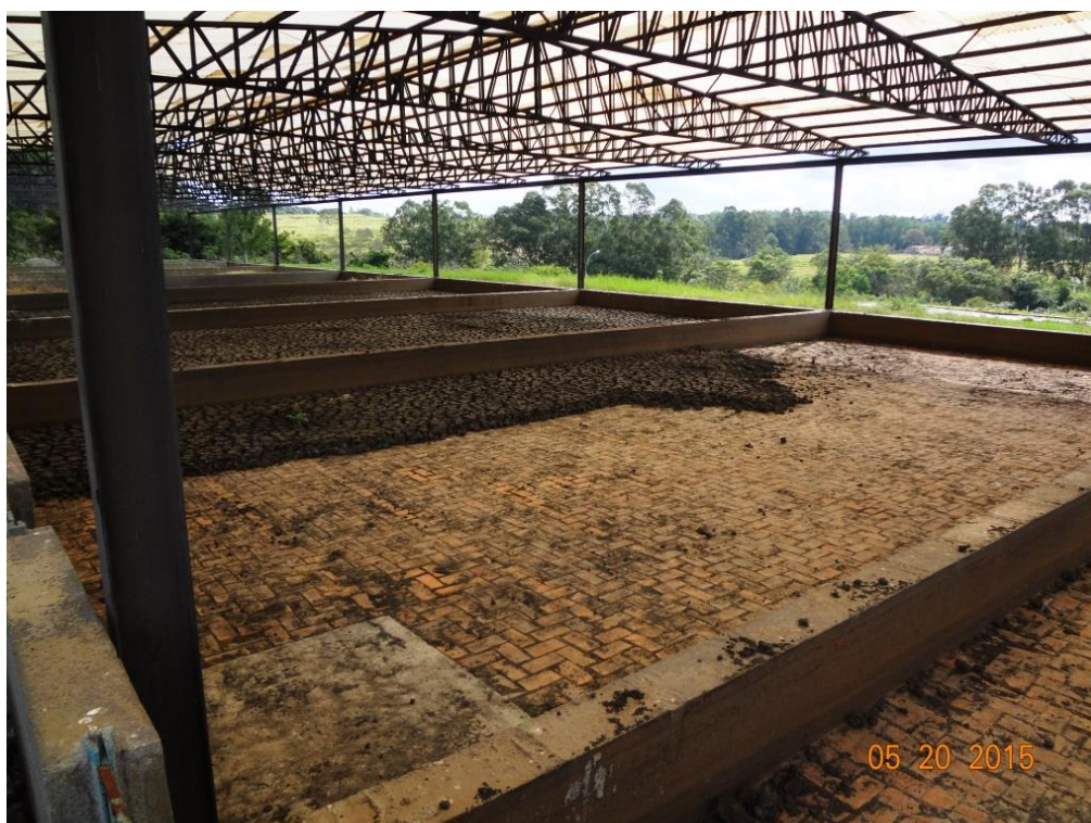
Figura 13 – Leitos de secagem cobertos dos lodos da ETE oeste de Adamantina.
