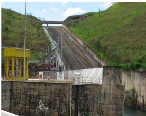
Figura 15: Vertedouro de superfície
