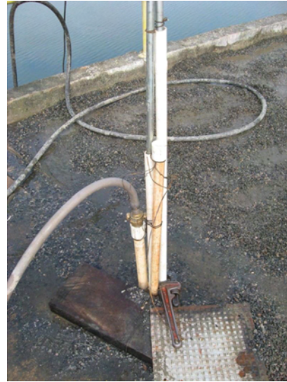
(b) Aplicação de graute para chumbamento
