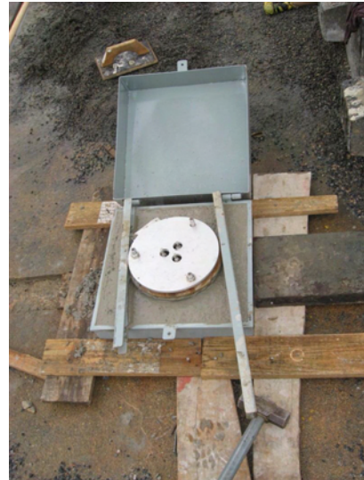
(b) Chumbamento com a caixa de proteção
