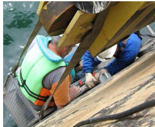
(b) Fixação dos apoios intermediários na parede I
