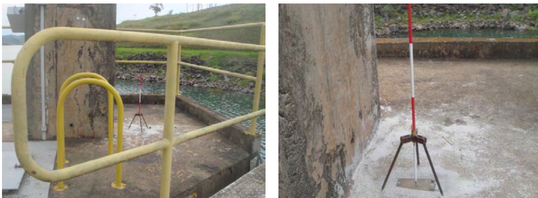
Figura 40: Baliza centrada em MS na laje da tomada d'água
