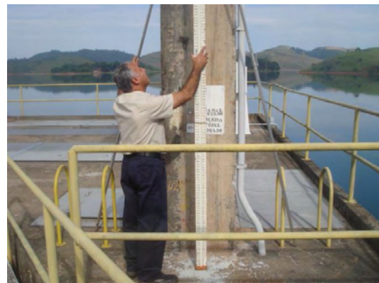
Figura 46: Mira centrada no MS da tomada d'água
