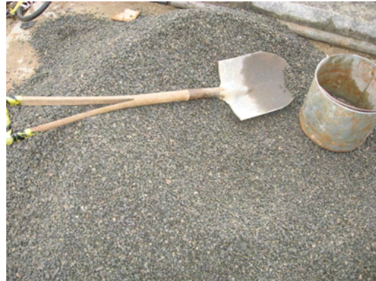
Figura 63: Pedrisco para preenchimento dos furos
