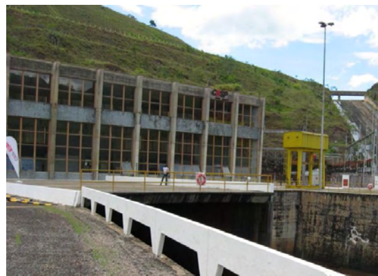
Figura 16: Casa de força
