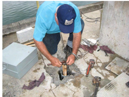
(b) Ajuste das hastes para receber a cabeça de leitura
