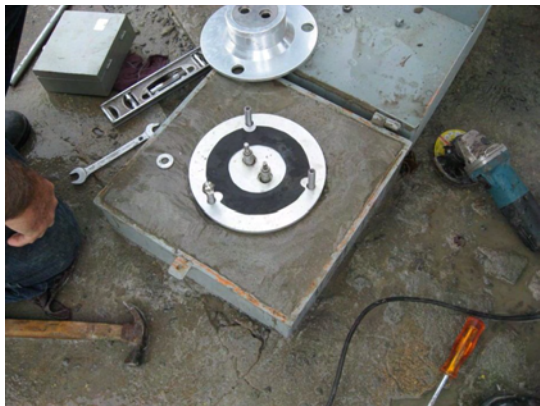
(c) Instalação da cabeça de leitura
