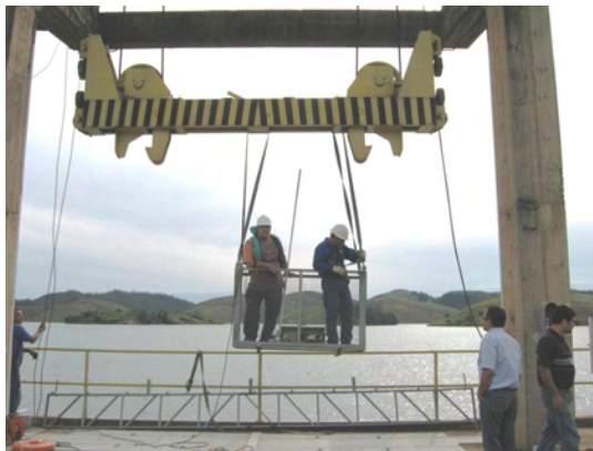
(a) Ponte rolante com andaime suspenso
