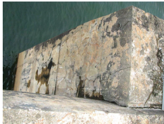
(d) Vista lateral direita (muro guia direito)
