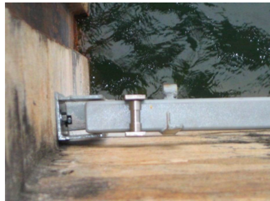
(d) Viga metálica posicionada
