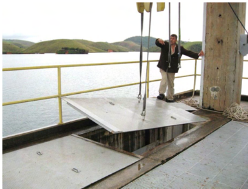
(a) Local de instalação do aparato com LVDT
