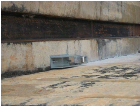
(c) Apoio da extremidade livre e cantoneira guia
