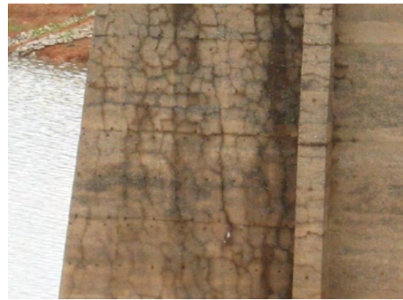
Figura 27: Fissurações aleatórias nas paredes externas e contrafortes
