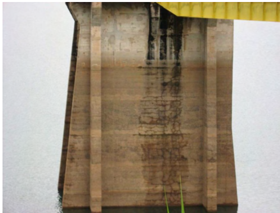
Figura 27: Fissurações aleatórias nas paredes externas e contrafortes
