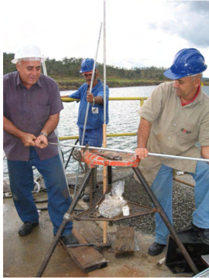
(a) Colocação das hastes no tubo
