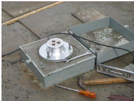
(c) Instalação da cabeça de leitura
