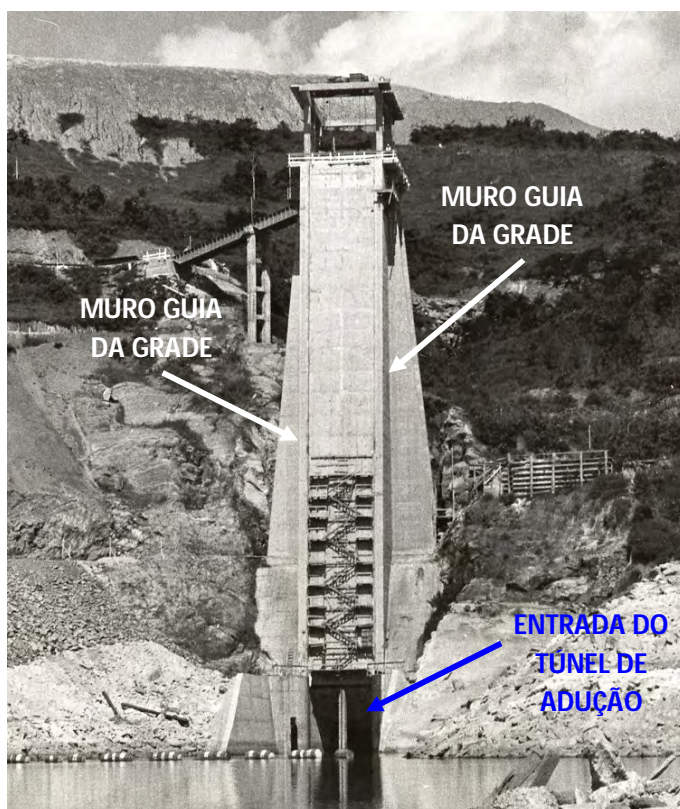
Figura 17: Tomada d'água em construção. Vista frontal
