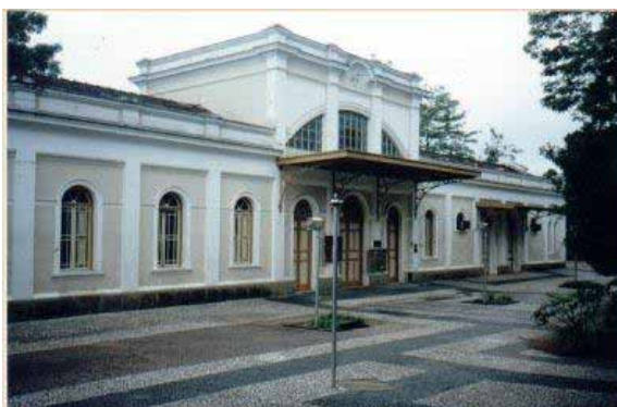
FIGURA 12 – FOTOGRAFIA DA FACHADA ATUAL DA ESTAÇÃO FERROVIÁRIA DE AMPARO, CONSTRUÍDA EM 1875
