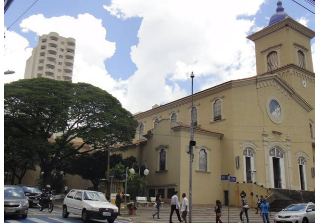
Figura 18 – Vista parcial da Igreja N.S. das Dores. Fonte: Própria-Out./2013
