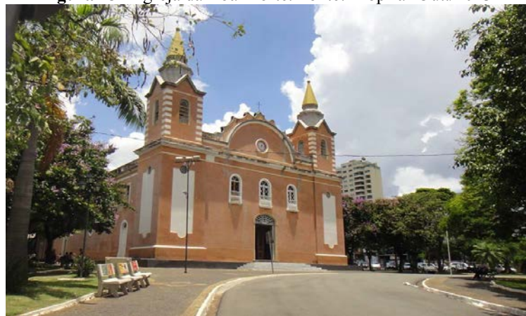
Figura 23 – Igreja da Boa Morte. Fonte: Própria- Out./2013
