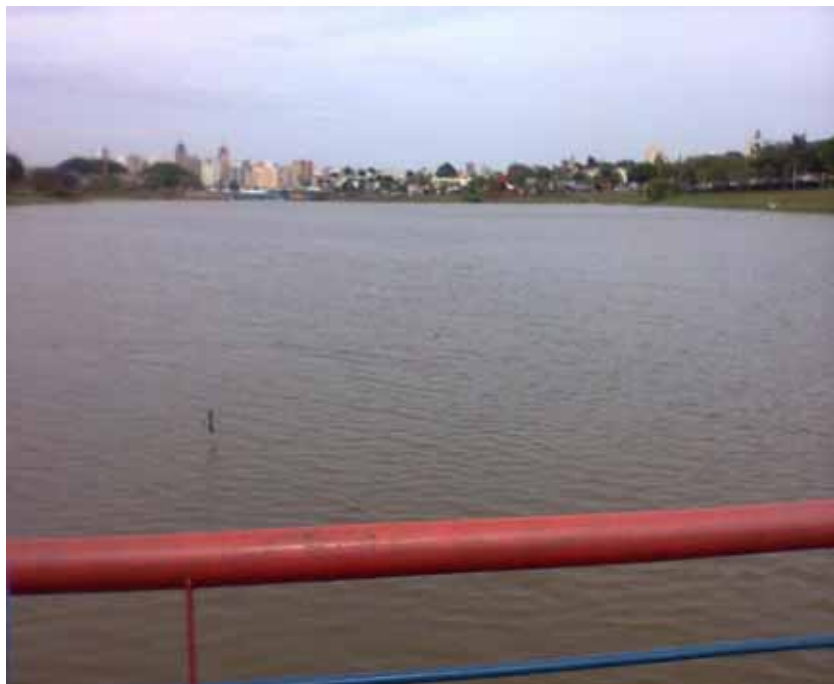
Captação Rio Preto – São José do Rio Preto
