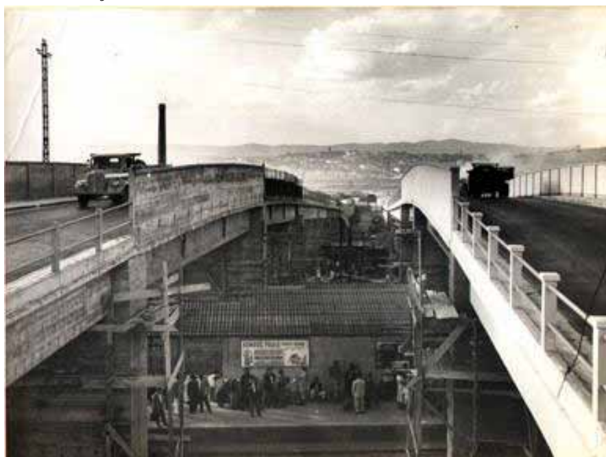
Figura 6 – Construção do viaduto sobre a linha férrea da CPTM — Obra concluída (1954)
