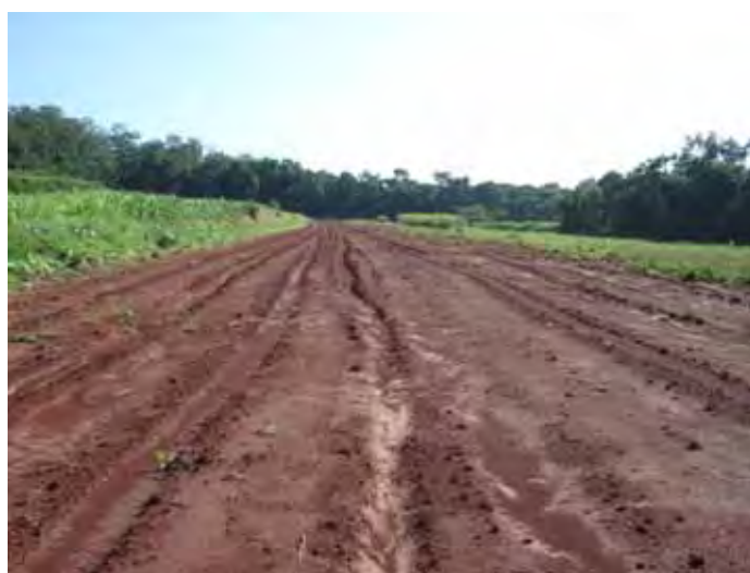
Figura 6 – Pista de solo mobilizado.
