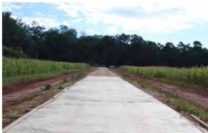
Figura 4 – Pista de concreto.
