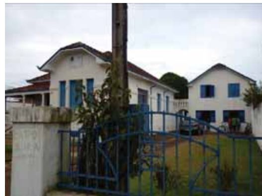
Figuras 20 – Casa do projeto Usina de Sonhos. Parte lateral utilizada para capoeira.
