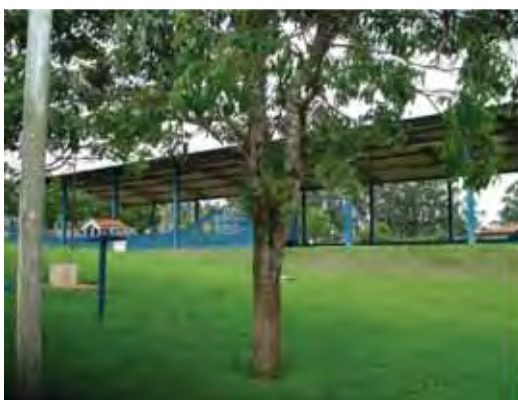
Figura 53 – Pista de malha e bocha, próximas à entrada, à direita.
