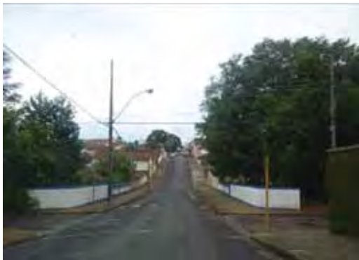
Figura 05 – Via muito importante por ser a única que liga o centro a um grande bairro da cidade – atravessa a linha férrea.
