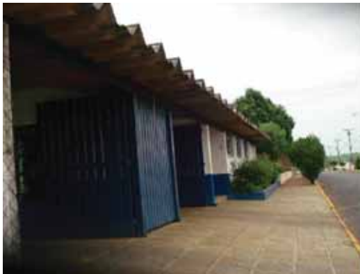
Figura 43 – Entrada única de acesso ao complexo.
