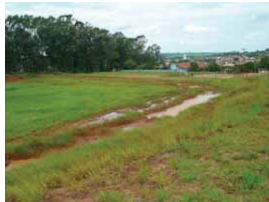
Figura 68 – O mesmo local anterior, ao fundo da EMEFEI, com ligação direta àquela entrada desativada.
