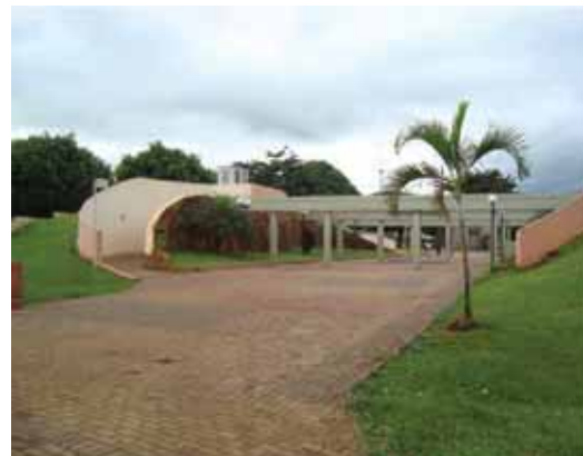
Figura 101 - Estruturas dos banheiros.
