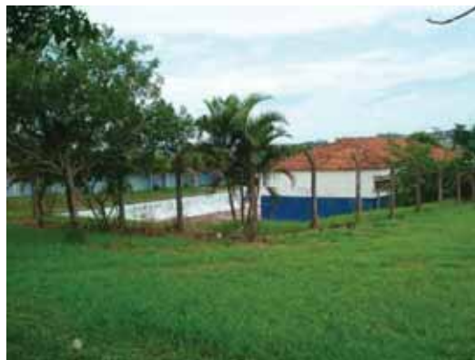
Figura 64 – Estrutura de vestiário e piscina, isolados do restante e sem uso atualmente.
