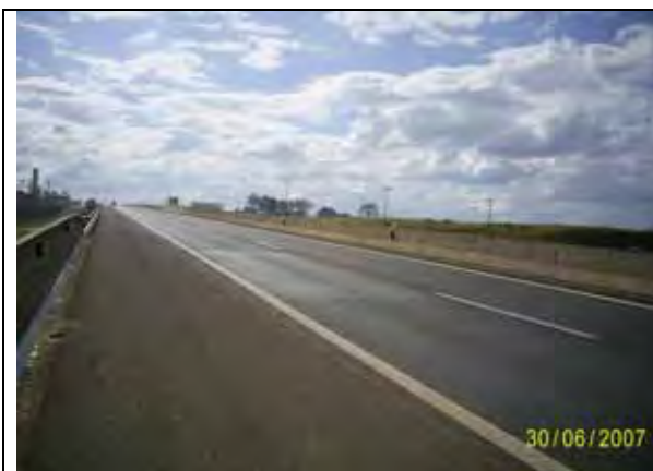
Foto 25 – Local, Km 405, SP - 334, na chegada a Franca, reta com declive e presença de construções e acostamento.
