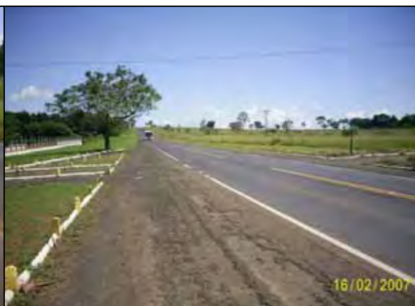
Figura 20 – Km 407 da SP - 334, apresentando os fatores condicionantes reta/plana e topografia plana, além de construções, acostamento e atropelamentos \geq 5 (n = 12).
