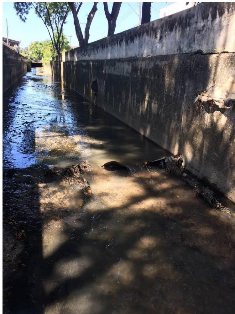
Figura 41: Intervenção R3. Foto tirada em 24/02/2018
