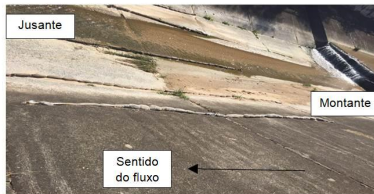
Figura 27: Intervenção realizada no córrego R2.
