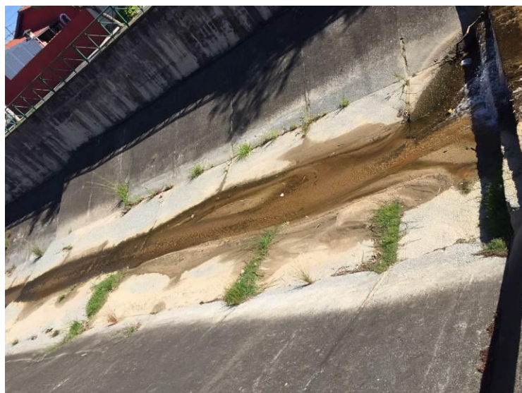
Figura 39: Intervenção R2. Foto tirada em 24/02/2018.
