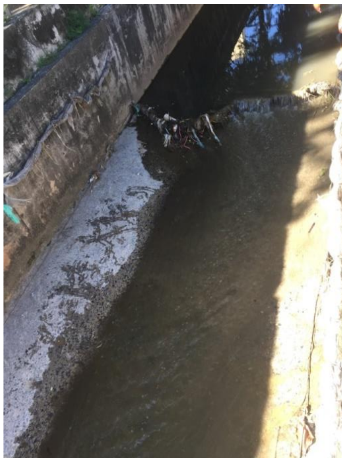
Figura 37: Retenção de sedimentos e/ou sólidos grosseiros pós-intervenção no rio 3. Foto tirada pela autora em 10/06/2017.
