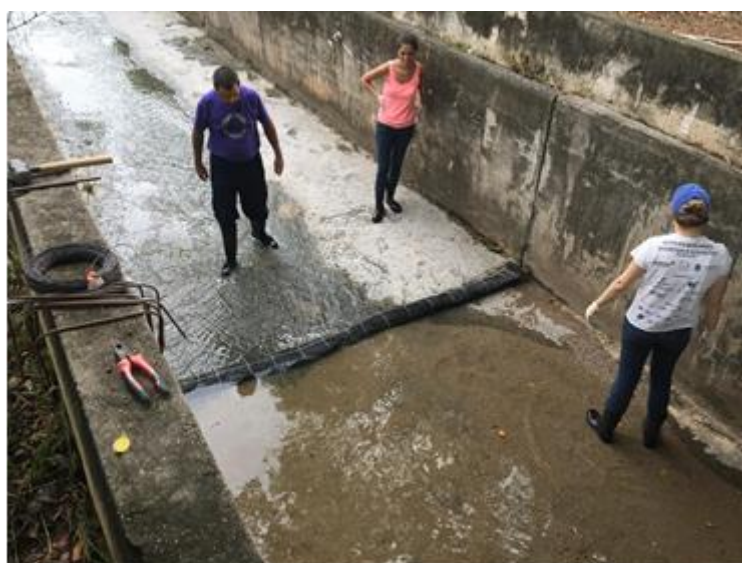
Figura 33: Detalhe da instalação da mini-barragem transversal no córrego R3. Integrantes do projeto da esquerda para a direita: Professor Alexandre, Kristiane e Gabriela.
