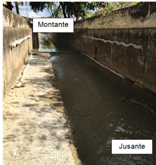
Figura 28: Intervenção realizada no córrego R3.
