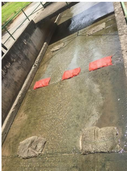
Figura 22: Intervenção realizada no R1. Sacos de juta com brita (R1).
