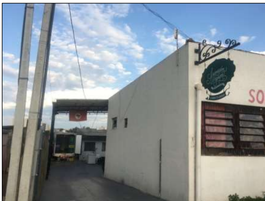
Figura 14 - Armazém do Campo de Cascavel
