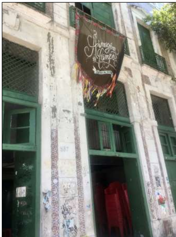
Figura 24 - Fachada do Armazém do Campo de Recife
